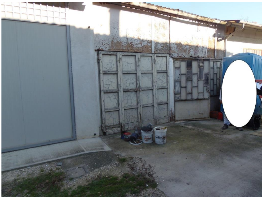
Vista esterna del fabbricato ad uso servizi (portone d'accesso)
