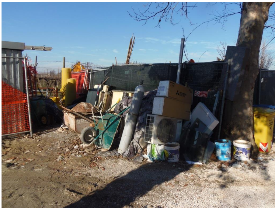
Vista esterna area cortilizia (materiale e attrezzatura edilizia varia)
