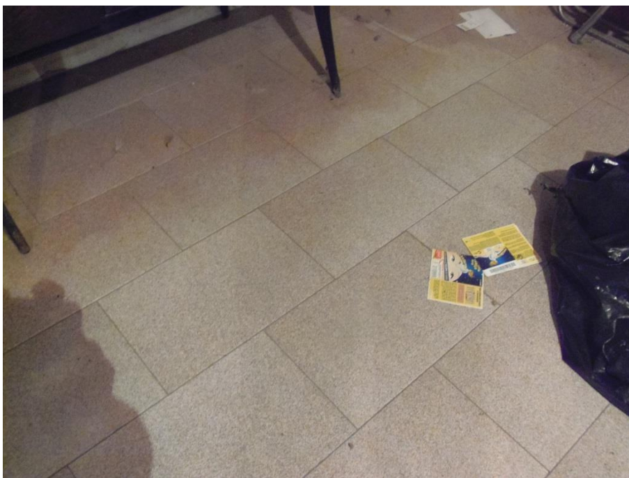
Vista interna del fabbricato (pavimenti)
