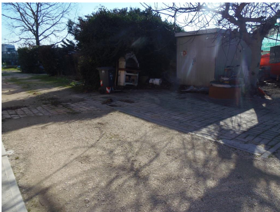
Vista esterna area cortilizia (manufatti accertati privi di titolo autorizzativo)
