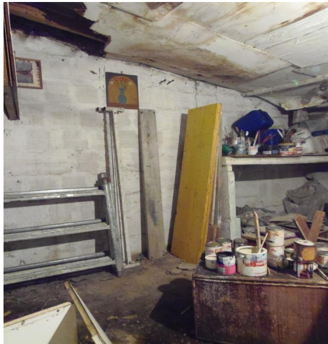
Vista interna del fabbricato ad uso servizi (rifiniture)
