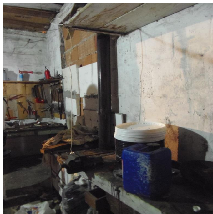
Vista interna del fabbricato ad uso servizi (rifiniture)
