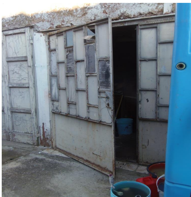
Vista esterna del fabbricato ad uso servizi (portone d'accesso)
