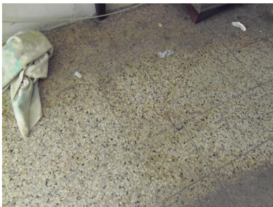
Vista interna del fabbricato (pavimenti)
