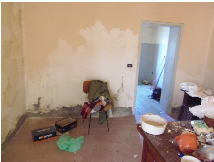
Vista interna del fabbricato (pavimenti)
