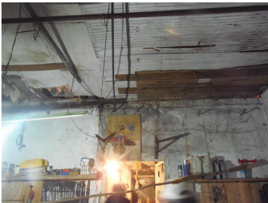
Vista interna del fabbricato ad uso servizi (rifiniture)
