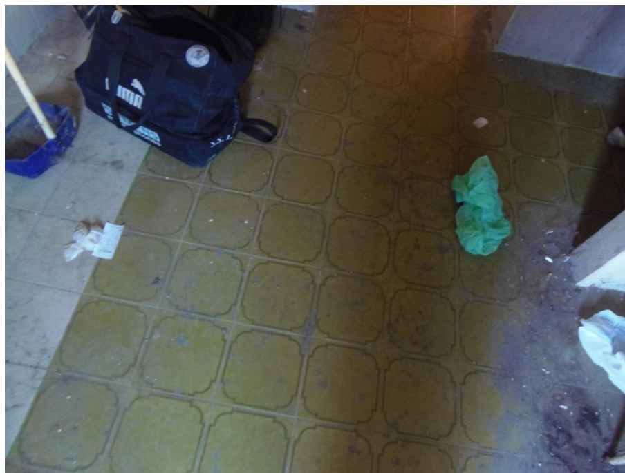
Vista interna del fabbricato (pavimenti)
