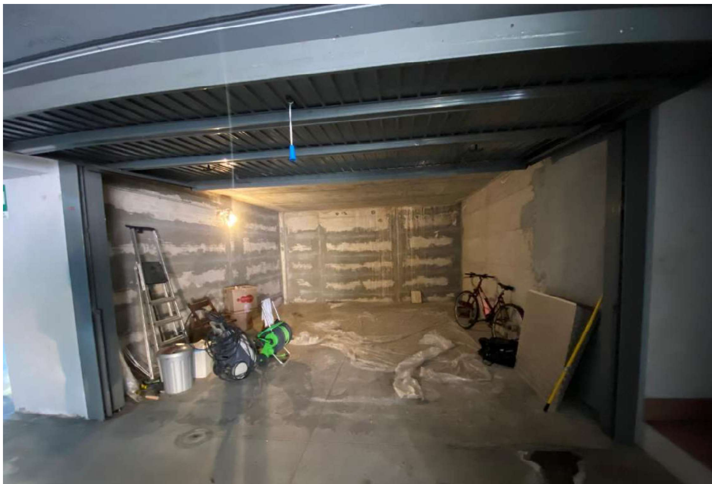
Vista interna box
