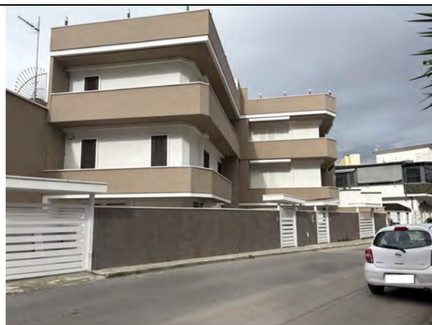
Fotografia n. 2 _ Prospetto su via Napoli, vista sud/nord
