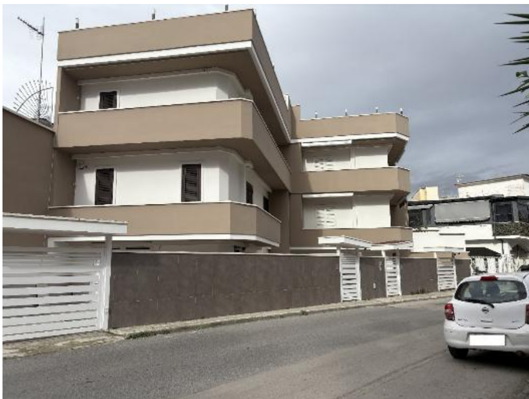
Fotografia n. 2 _ Prospetto su via Napoli, vista sud/nord
