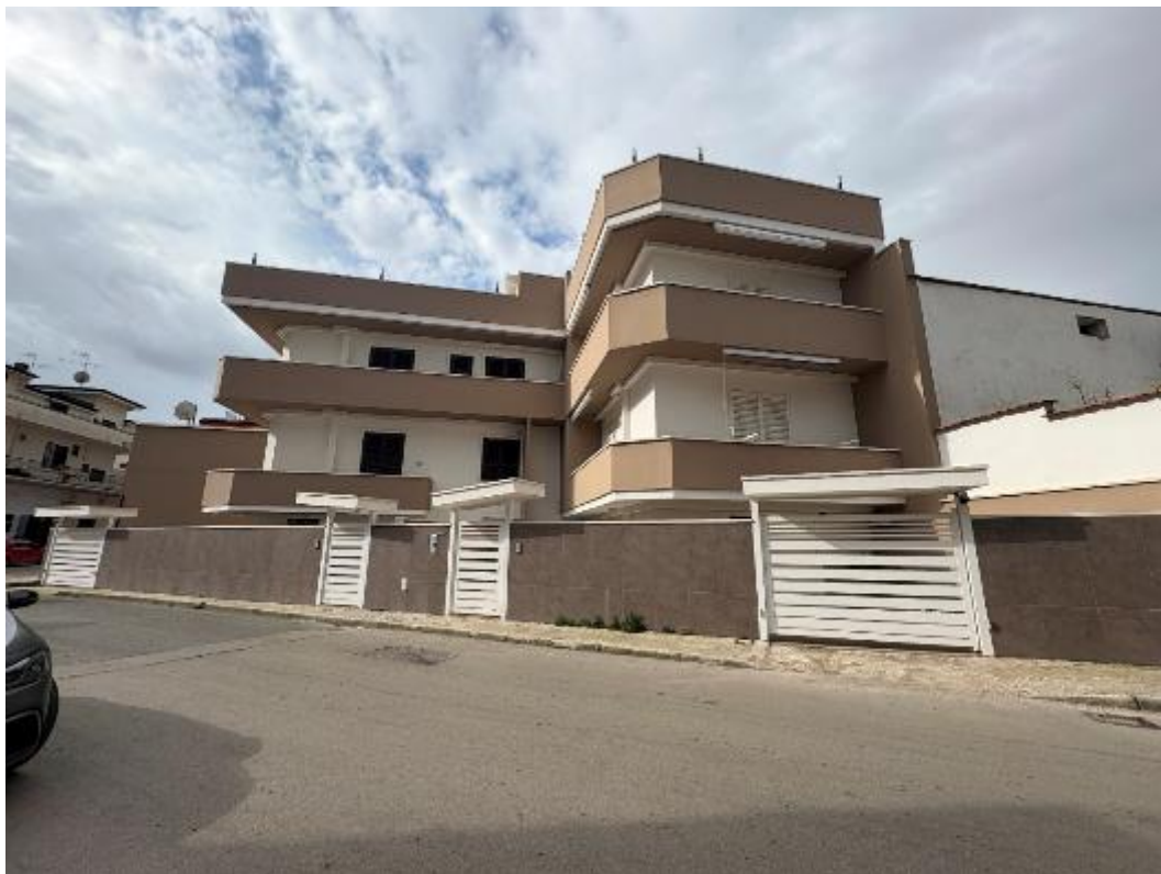
Fotografia n. 1 _ Prospetto su via Napoli, vista nord/sud
