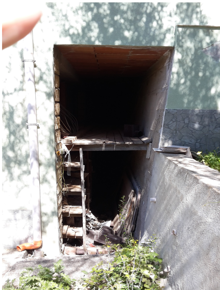
Foto n.10- vista esterna – intercapedine al piano seminterrato – lato sud.
