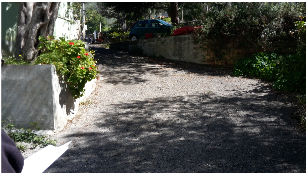
Foto n.9- vista esterna – rampa di accesso al piano seminterrato – lato sud.
