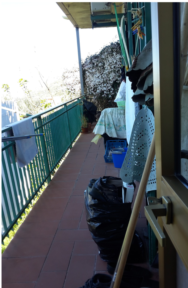
Foto n.18 – vista interno unità abitativa, Balcone lato ovest.
