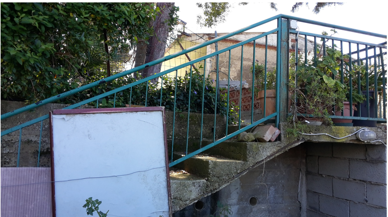
Foto n.26- vista esterna– lato nord – collegamento col piano seminterrato(Fg 5, Part. 1021, sub. 2).
