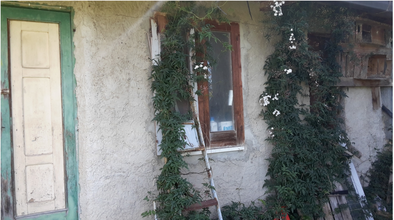
Foto n.23- vista esterna– piano seminterrato – Cantina – lato ovest (Fg 5, Part. 1021, sub. 2).
