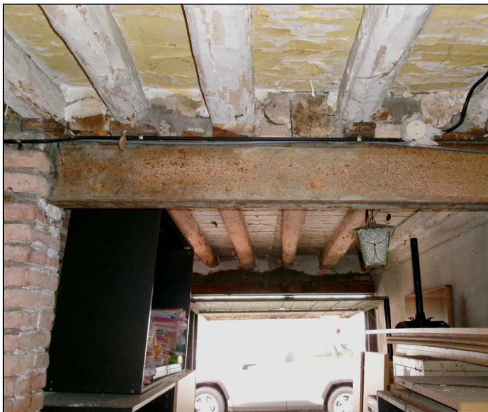
FOTO N°3 - VISTA SOLAIO DEL PIANO TERRA
