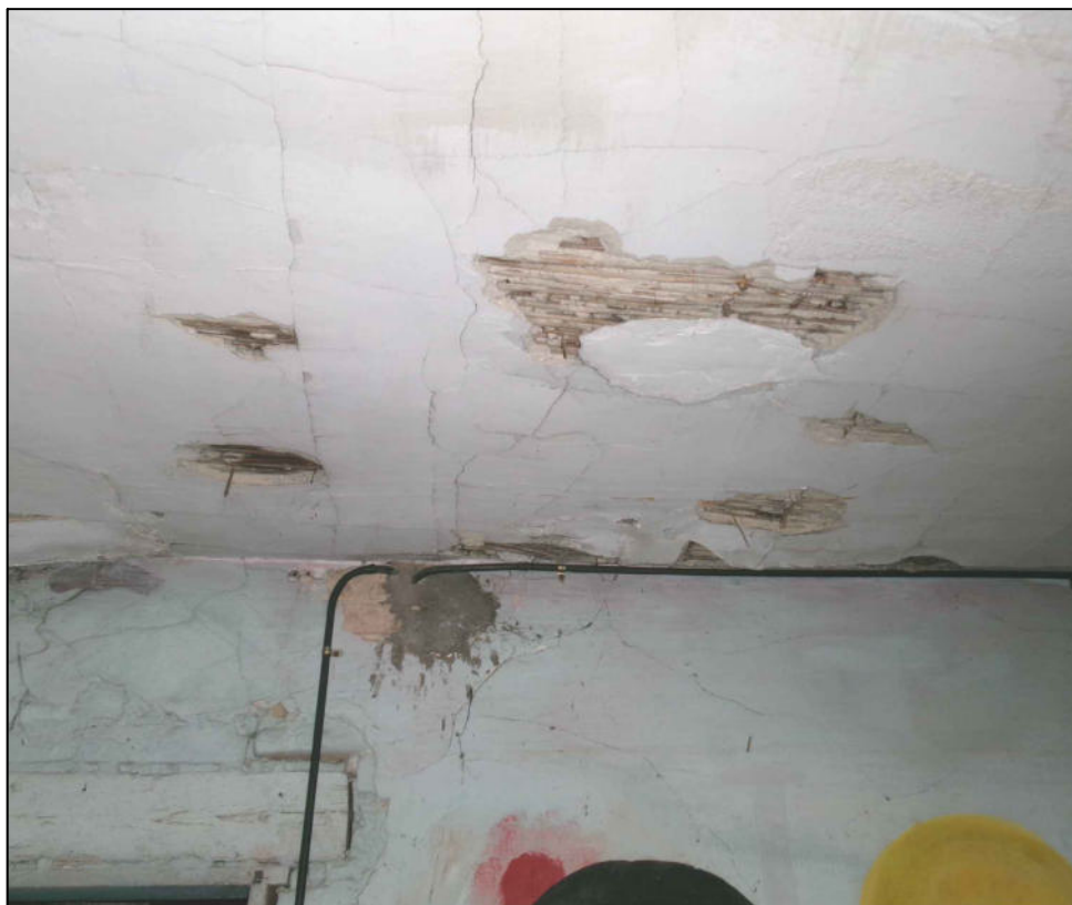
FOTO N°7 - VISTA DEL SOFFITTO
