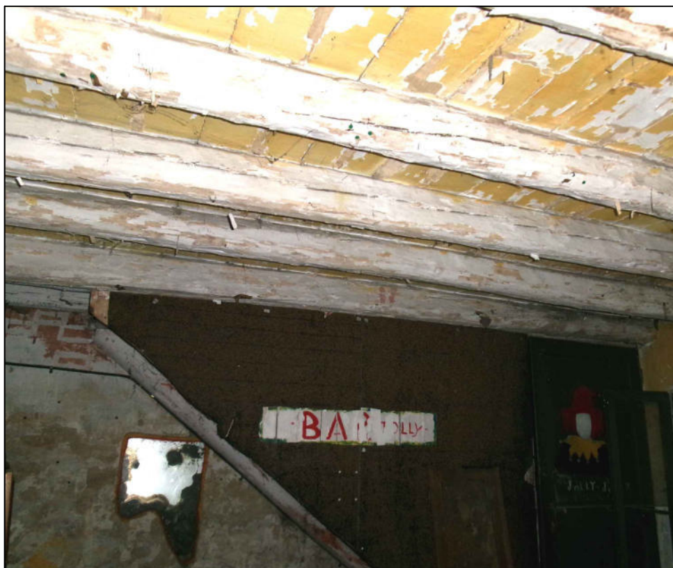
FOTO N°4 - VISTA DEL VANO SCALA
