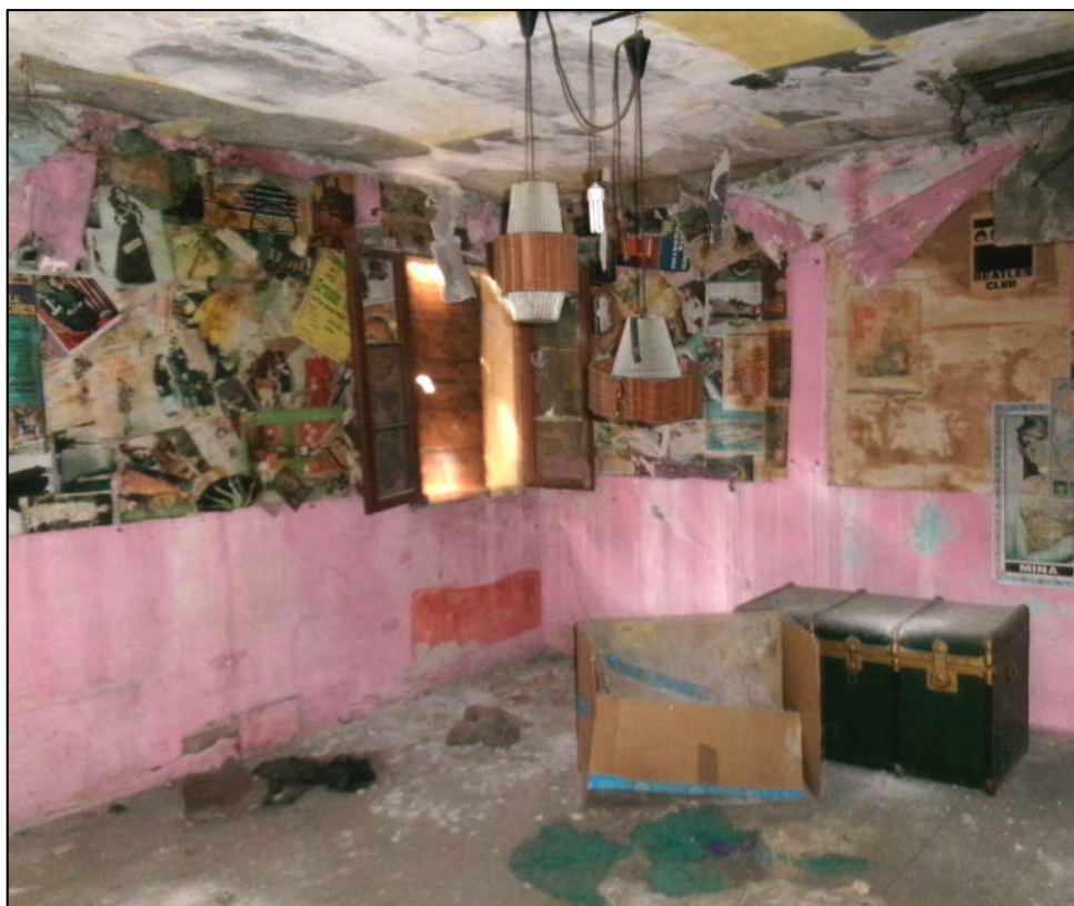
FOTO N°8 - VISTA DELLA STANZA LATO SUD AL PRIMO PIANO
