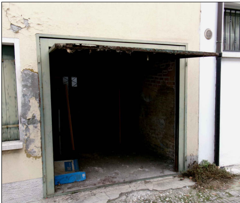
FOTO N°1 - VISTA DEL GARAGE
