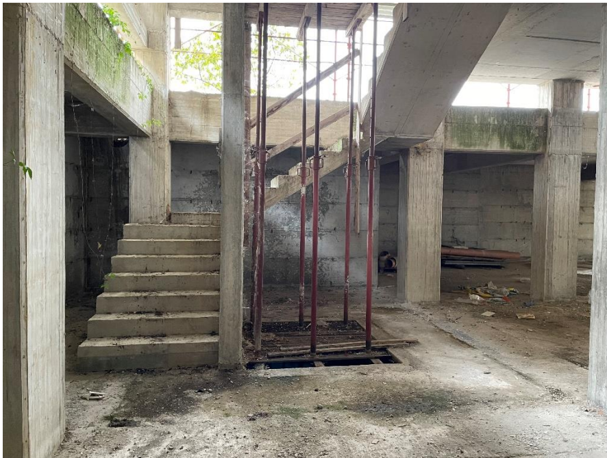
Foto n. 6: Vano scala piano interrato
