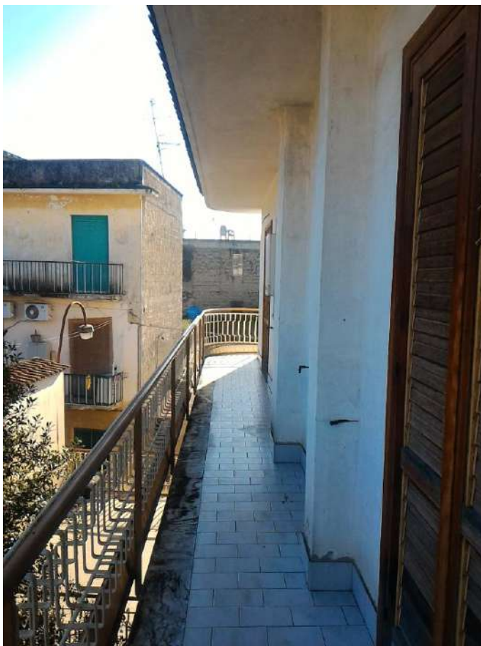
vista del balcone esterno
