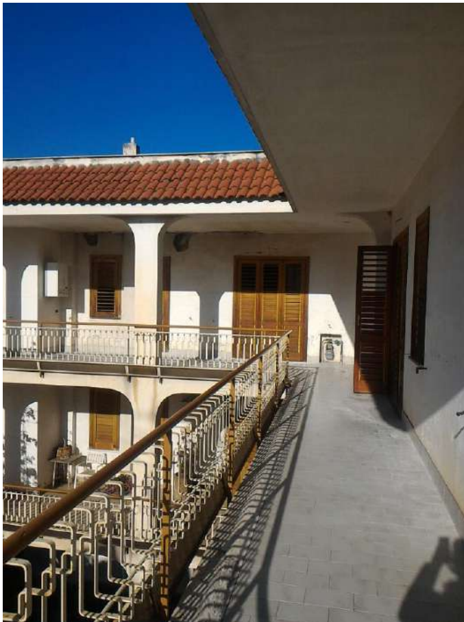
vista del balcone esterno
