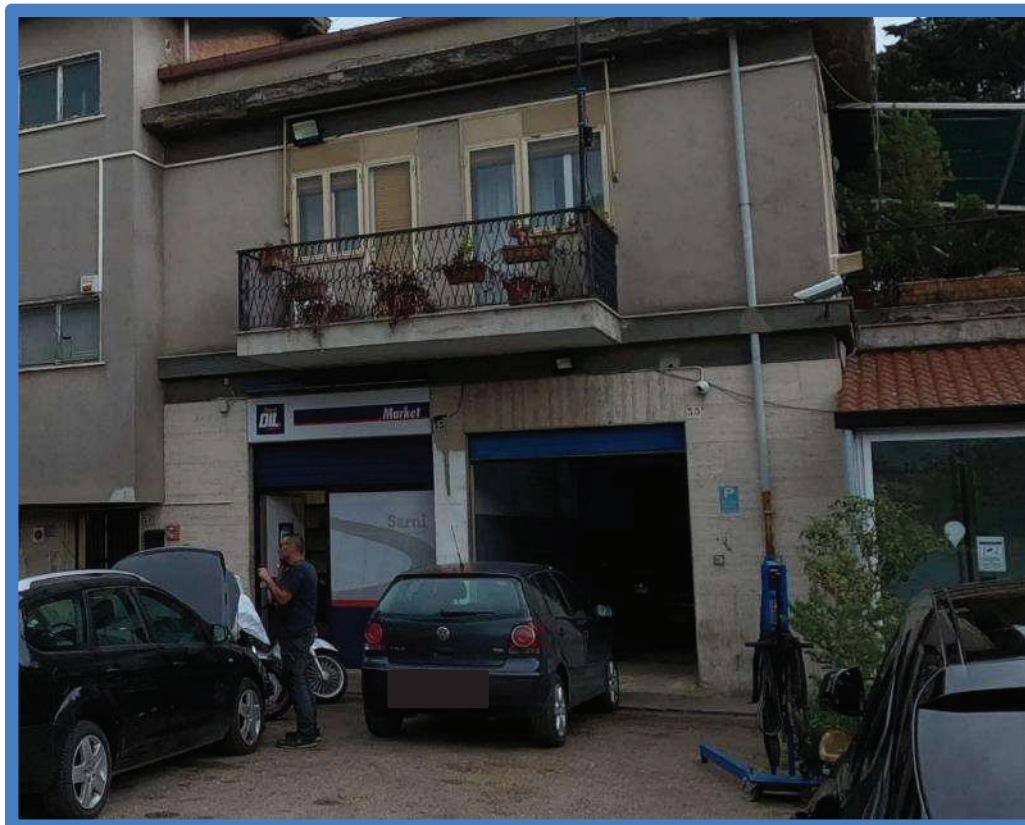
Documento fotografico 10 – LOTTO 1 - Locale officina
