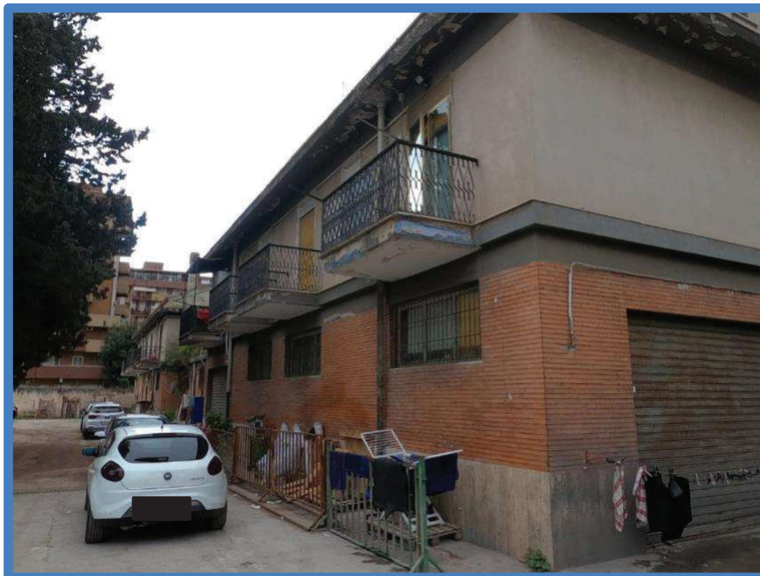
Documento fotografico 14 - Prospetto posteriore del fabbricato
