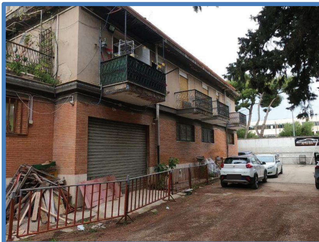
Documento fotografico 12 – Prospetto posteriore del fabbricato
