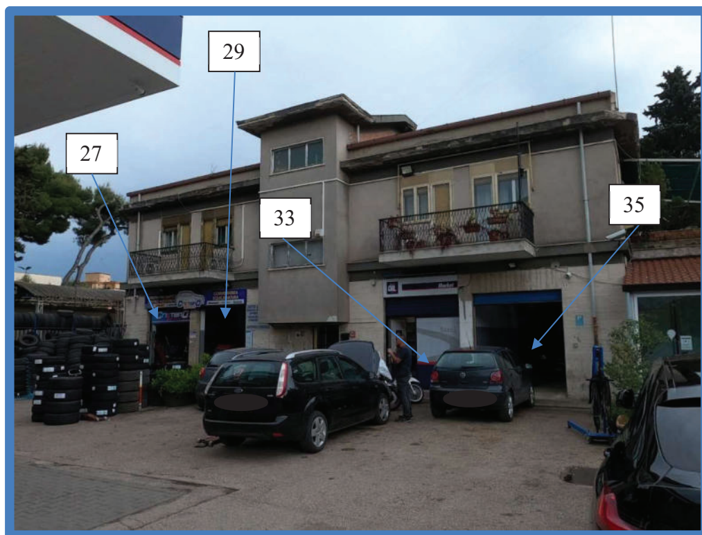
Documento fotografico 1 - Prospetto dell'edificio ospitante le unità immobiliari con indicazione dei civici di via Napoli
