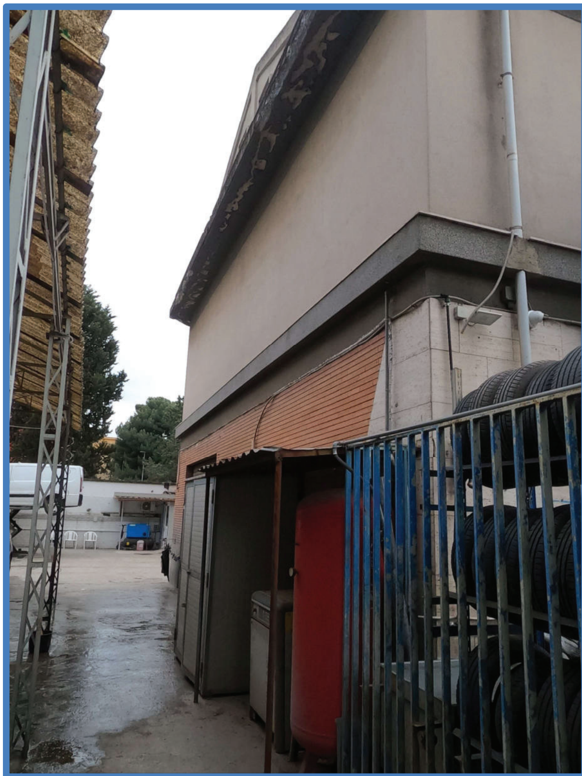
Documento fotografico 13 - Prospetto laterale del fabbricato
