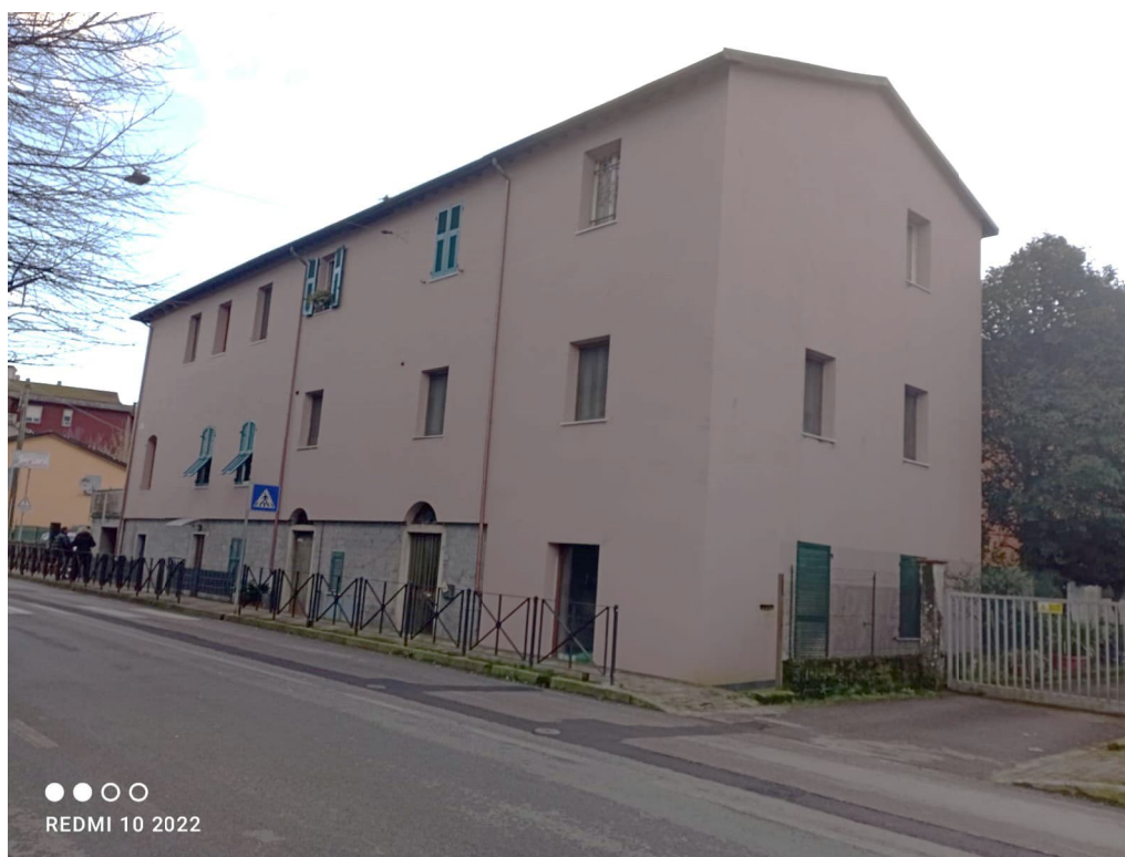
Figura 3 l'edificio condominiale di via Brigate Partigiane n. 32 Follo
