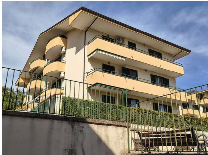
VISTA OVEST E SUD-OVEST
