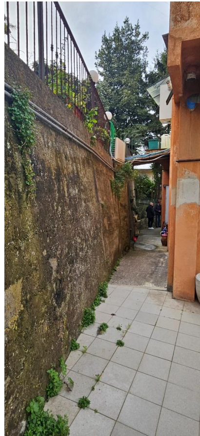
Accesso al portoncino di ingresso P.1
