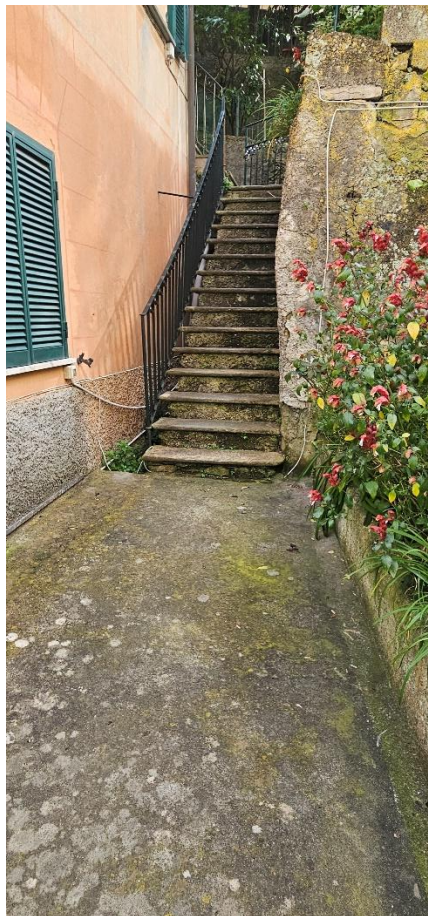
2^ rampa uso piano 1 e 2
