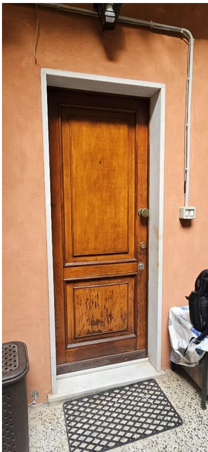
Portoncino ingresso lato sud
