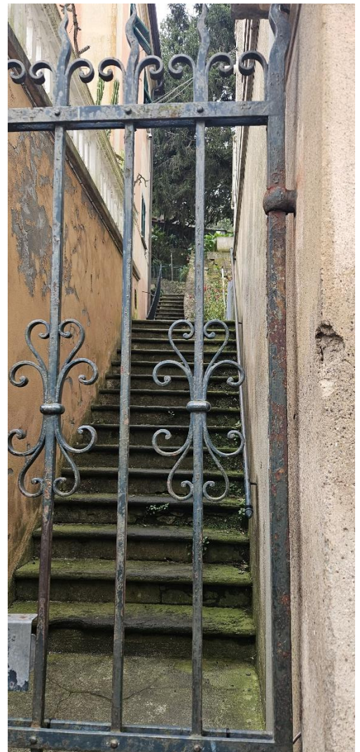
1^ rampa accesso comune
