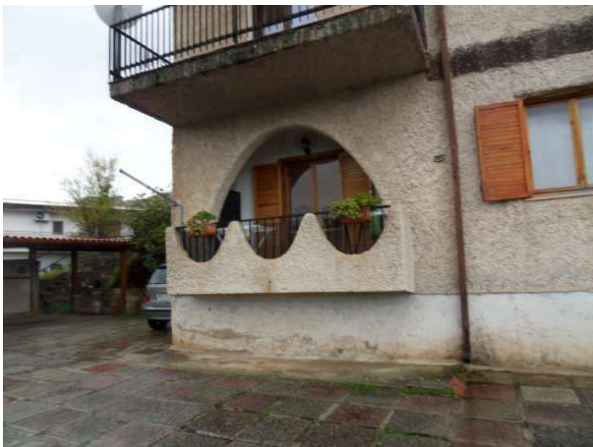
FOTO N. 42: Esterni Bene Immobile (Prospetto Nord-Est)
