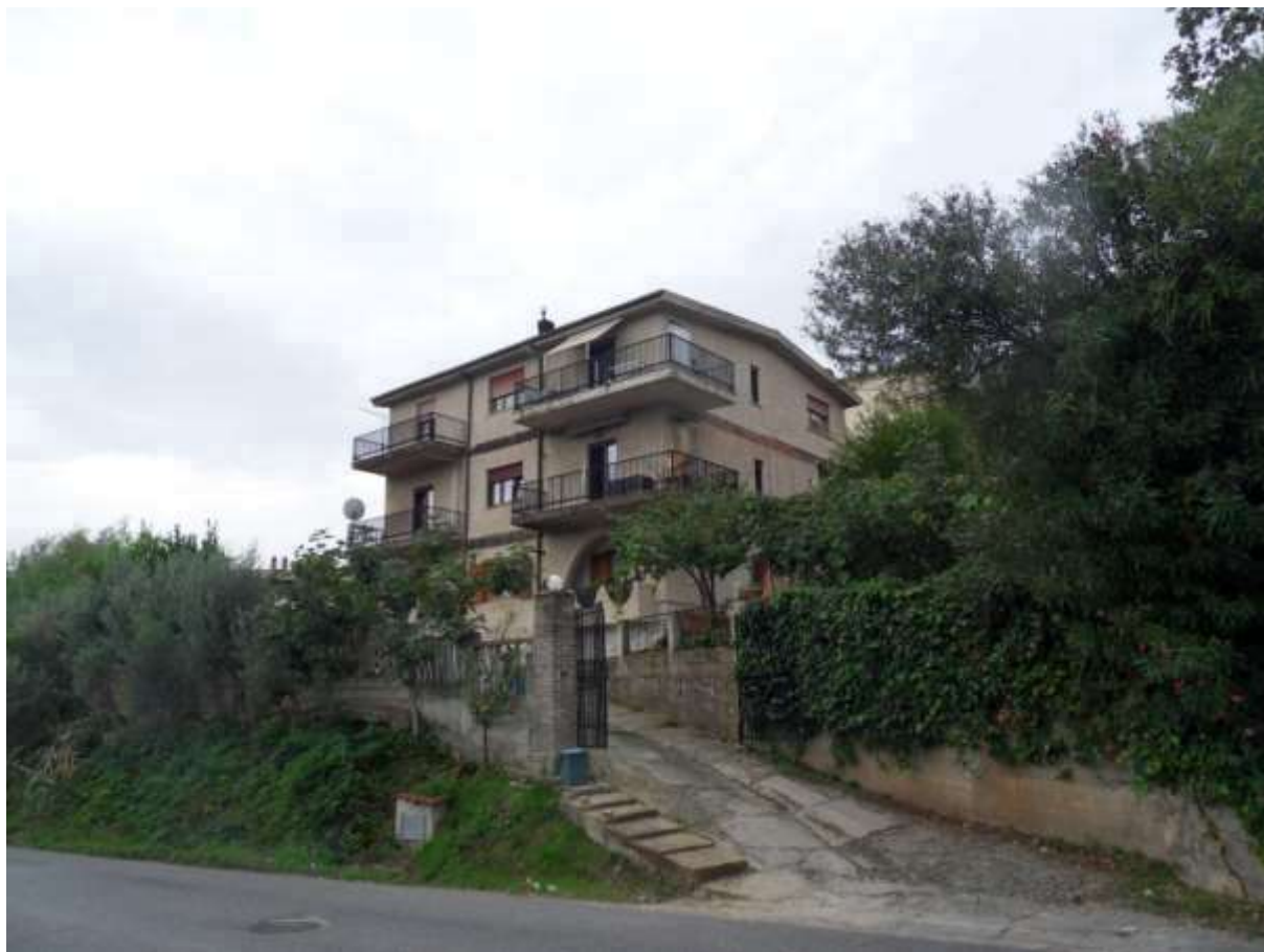
FOTO N. 1: Prospetto Nord-Est (da S.P. 257) Fabbricato.
