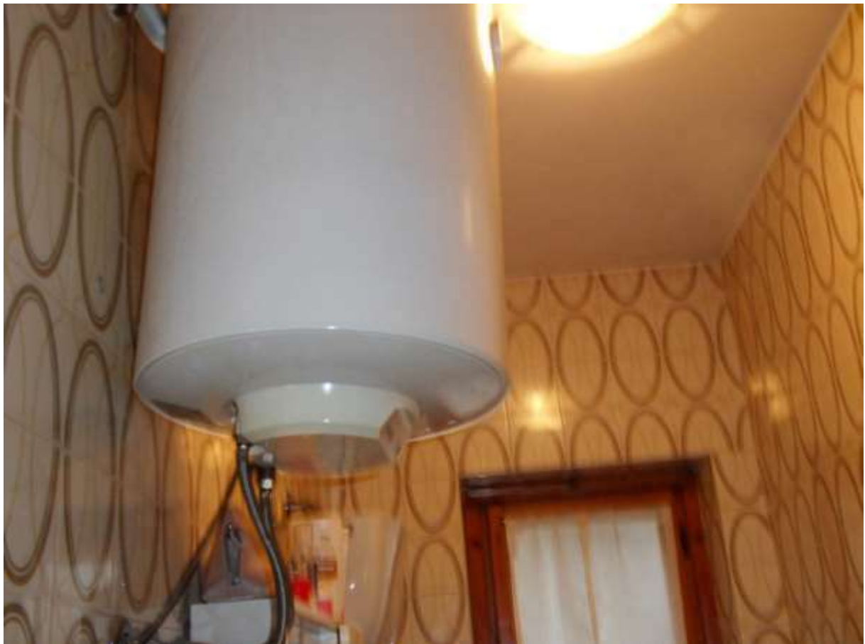
FOTO N. 17: Interni Bene Immobile
