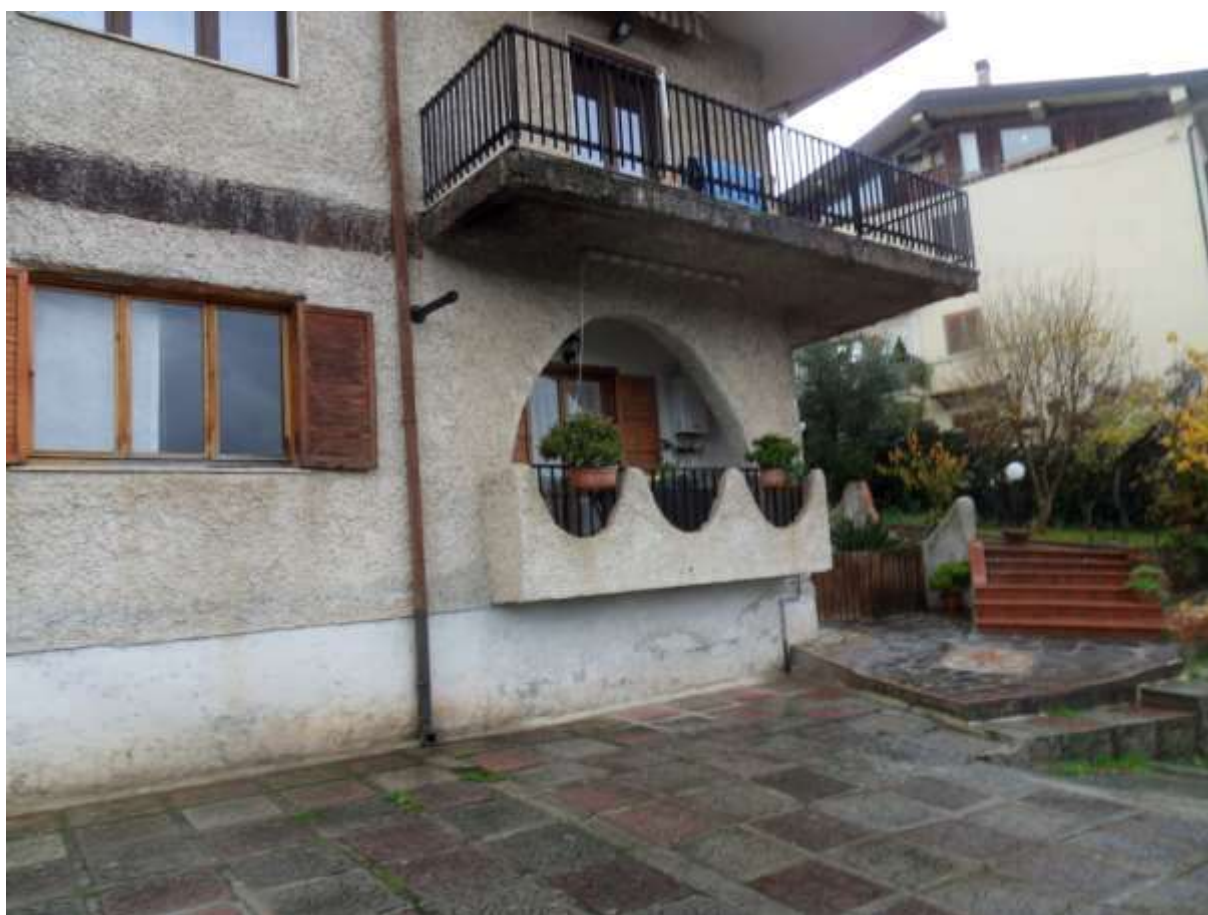
FOTO N. 40: Esterni Bene Immobile (Prospetto Nord-Est)
