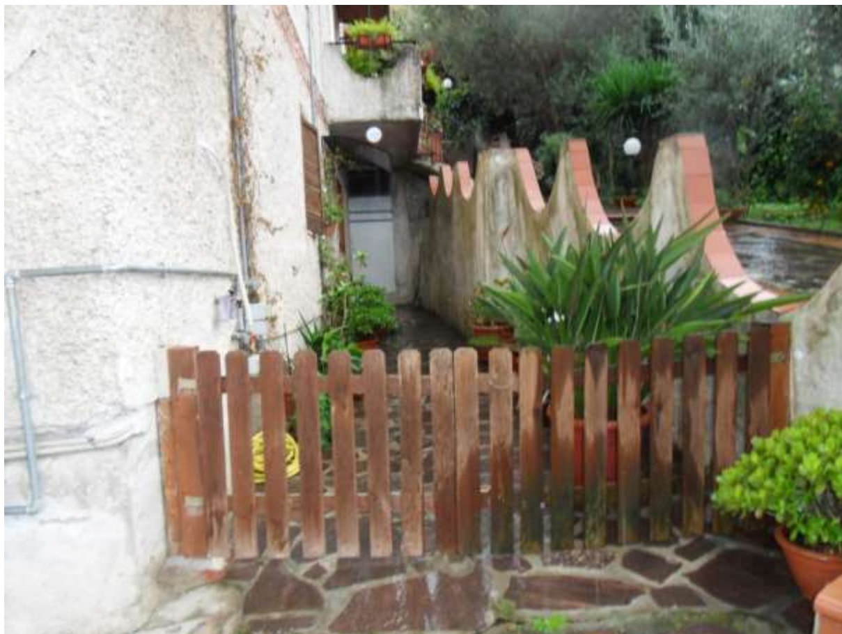
FOTO N. 3: Ingresso Vialetto verso il Bene Immobile.
