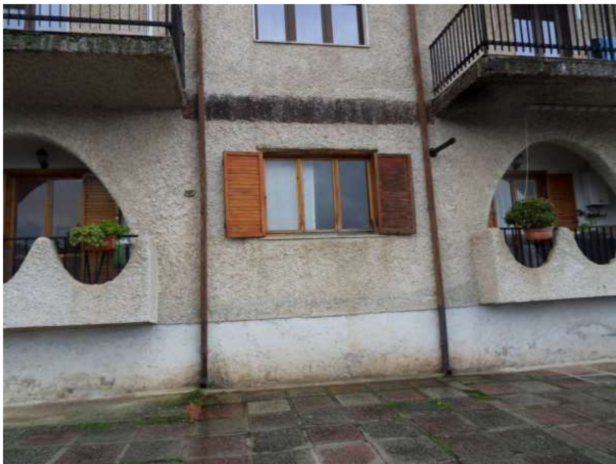
FOTO N. 41: Esterni Bene Immobile (Prospetto Nord-Est)
