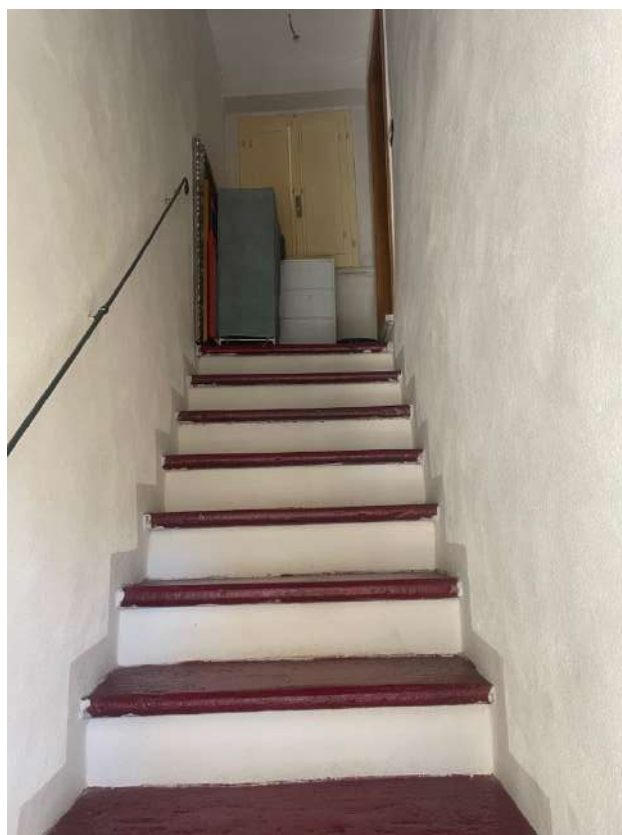
Scala di collegamento piano primo – piano secondo
