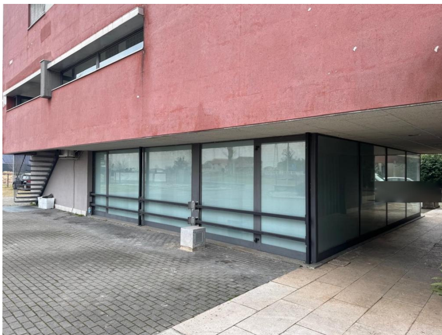
6. - vista panoramica lato Sud-Ovest
