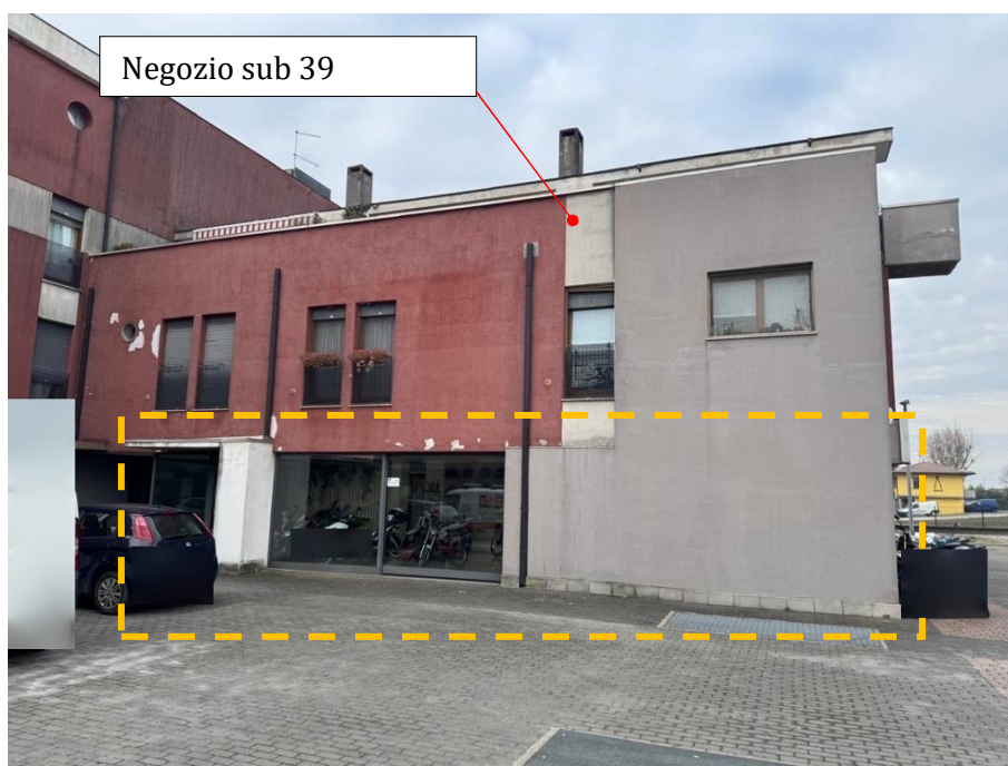
4. – vista panoramica lato Est
