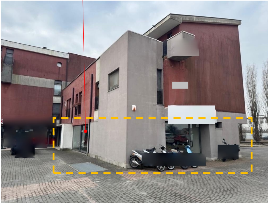
1. – vista panoramica lato Nord-Est
