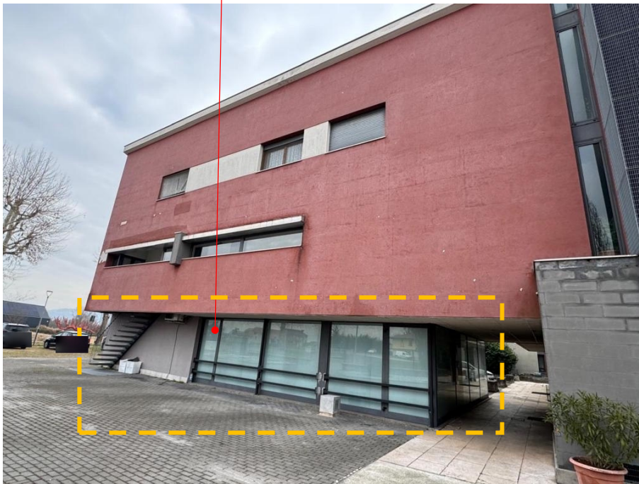
2. – vista panoramica lato Ovest
