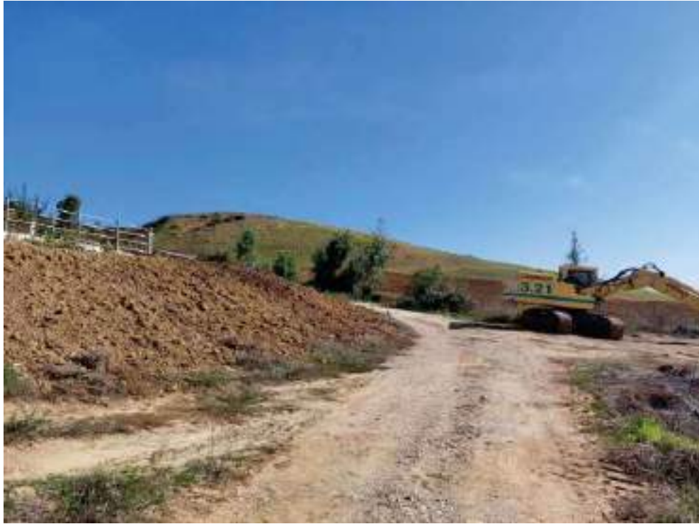
Foto 4 – Accesso al corpo “A”
