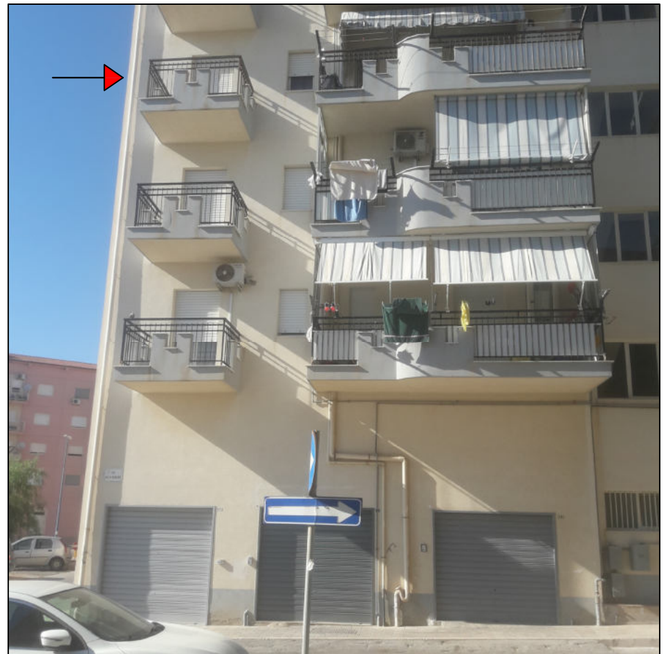
Foto 2) Prospetto principale del condominio su via Randone
