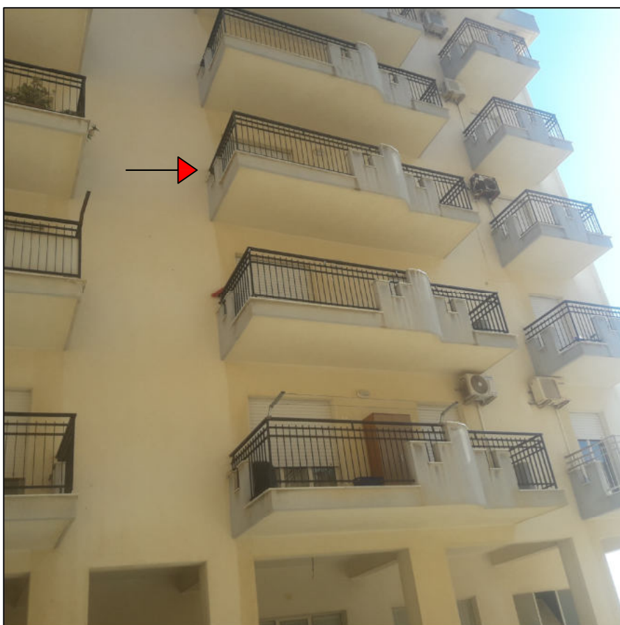
Foto 3) Prospetto secondario a nord
