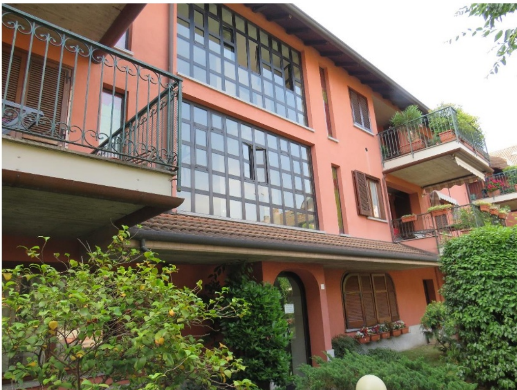
FACCIATA SU GIARDINO INTERNO
