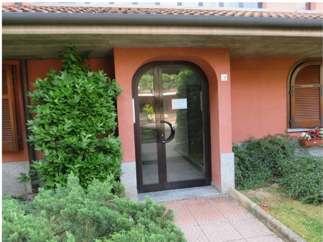
PORTONCINO DI INGRESSO ALL'IMMOBILE
