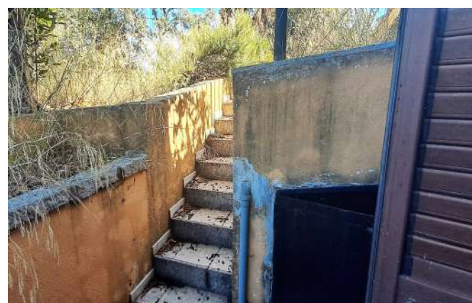
24. Scala di collegamento tra sub 19 e sub 20.
