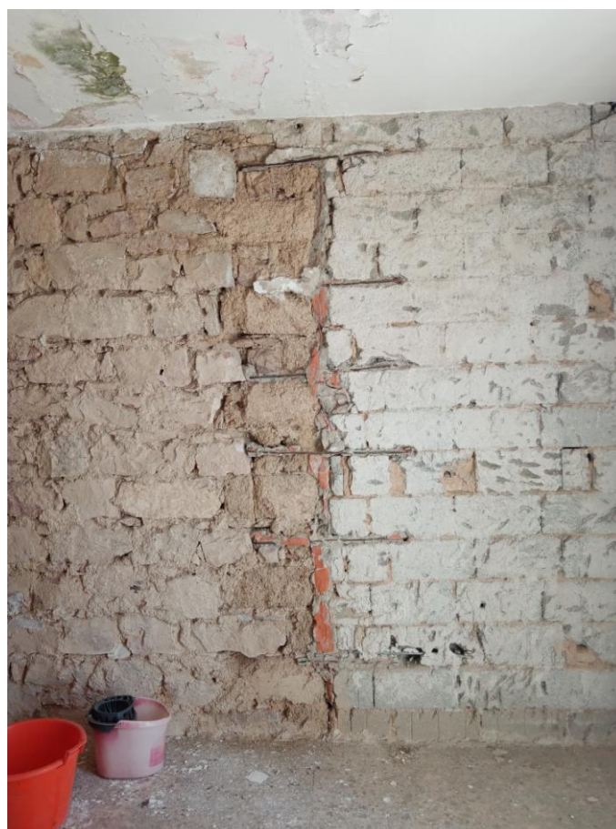
Foto 18_ particolare costruttivo della muratura portante perimetrale
