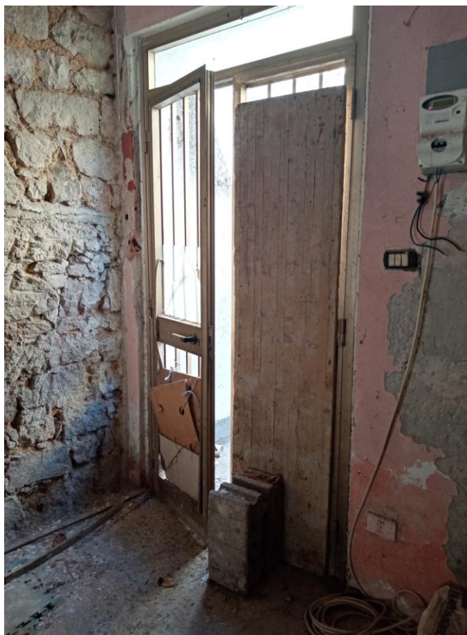
Foto 11_vista interna portoncino d'ingresso all'unità immobiliare
