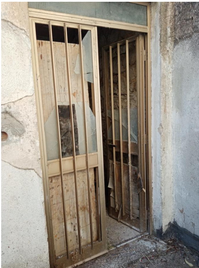
Foto 10_vista esterna portoncino d'ingresso all'unità immobiliare
