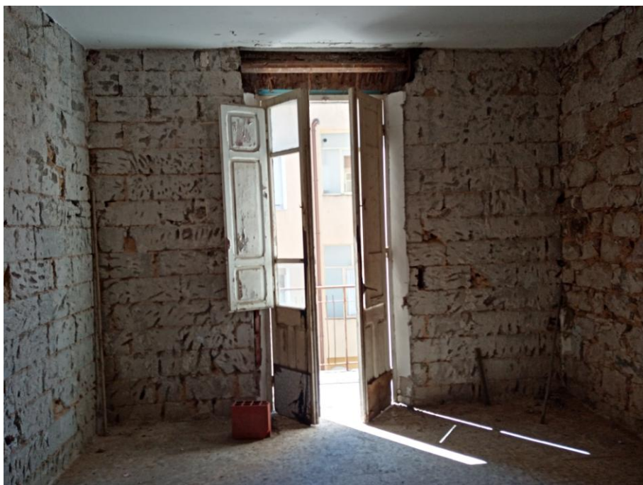
Foto 16_ vista interna della porta finestra in legno
