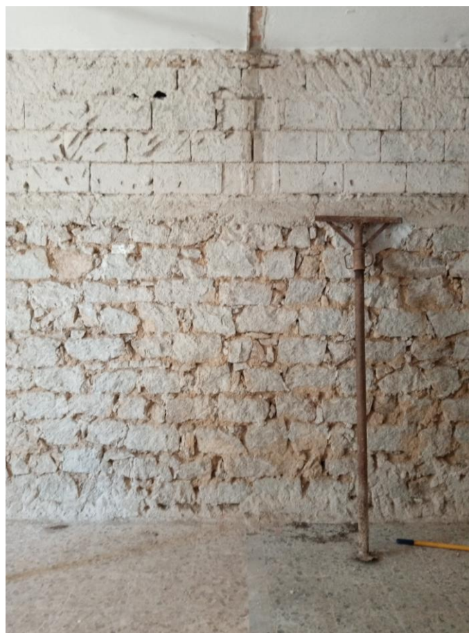
Foto 17_ particolare costruttivo della muratura portante perimetrale
