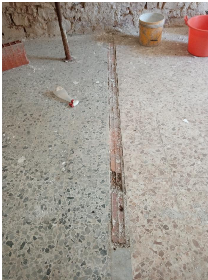
Foto 19_ particolare traccia della demolizione dei tramezzi interni
