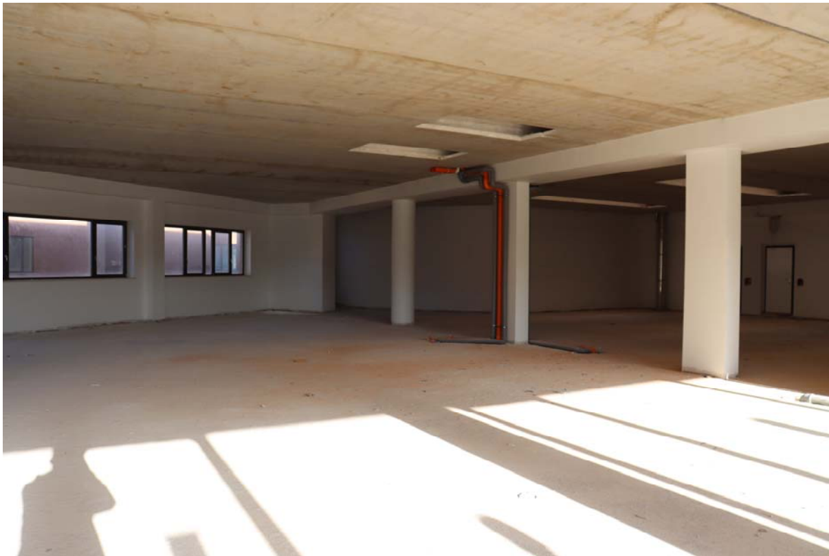
Foto 07 – Vista dell'interno del bene
