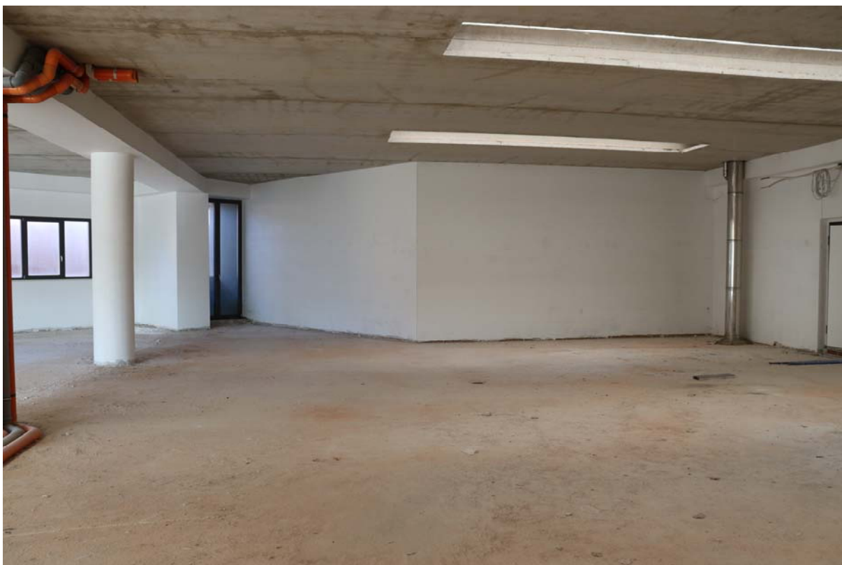
Foto 08 – Vista dell'interno del bene
