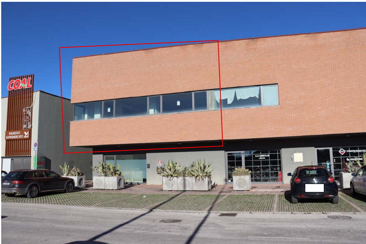
Foto 02 – Vista dell'unità immobiliare dal parcheggio esterno
