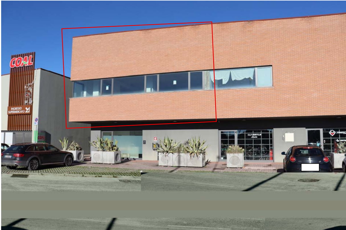
Foto 01 – Vista dell'unità immobiliare dal parcheggio esterno
