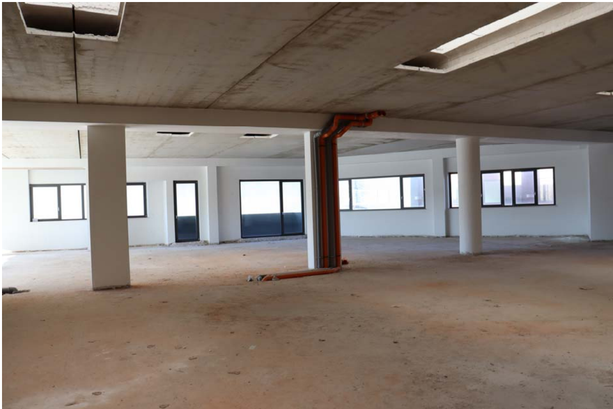
Foto 05 – Vista dell'interno del bene
