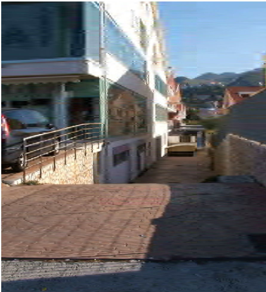
Foto n° 3 – Prospetto sud- Vista percorso carrabile
