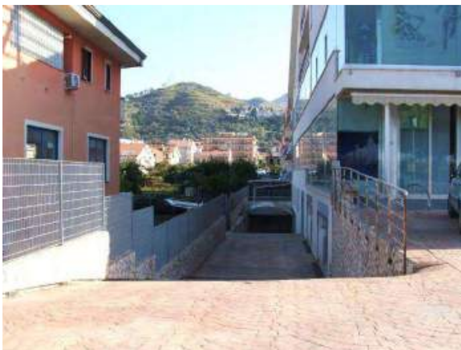
Foto n° 6 – Ingresso carrabile lato nord
