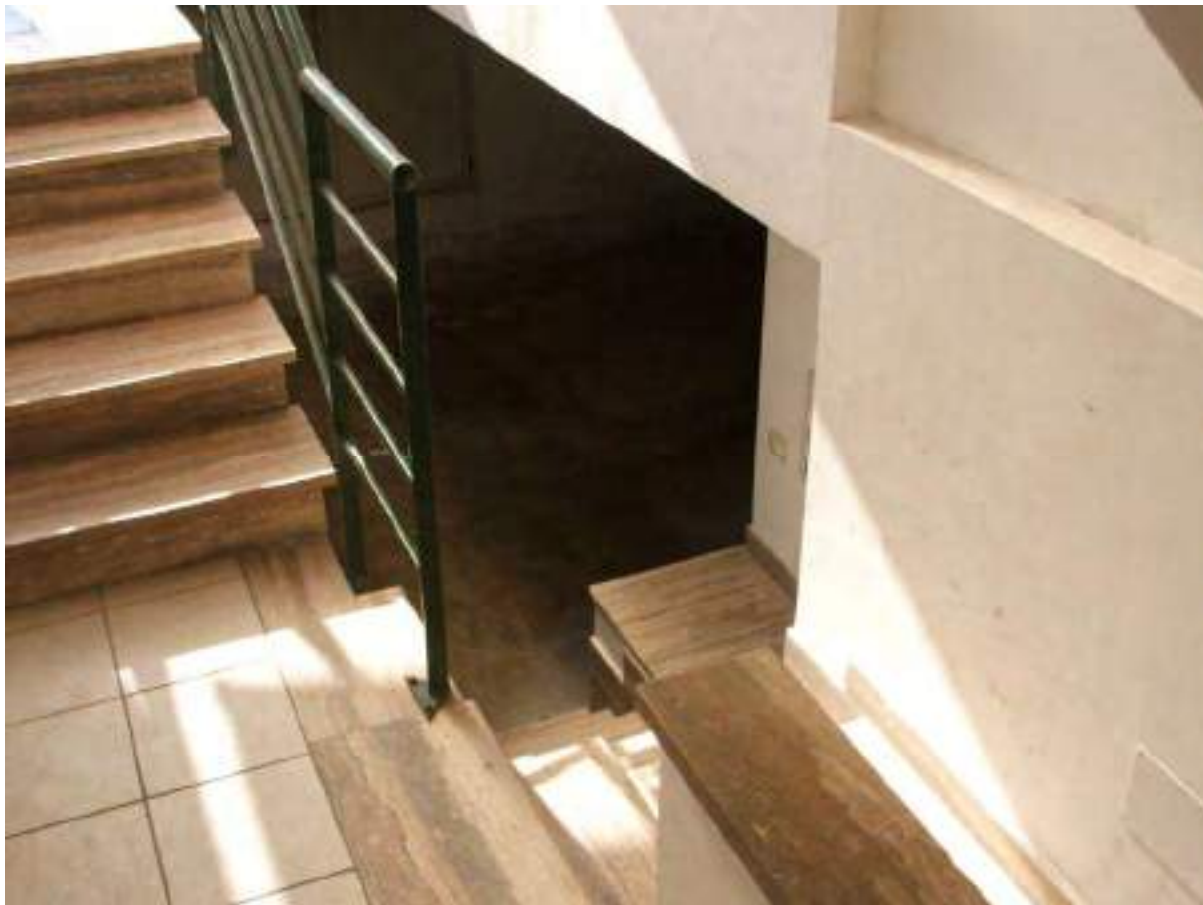
Foto n° 19 – Accesso al piano interrato
