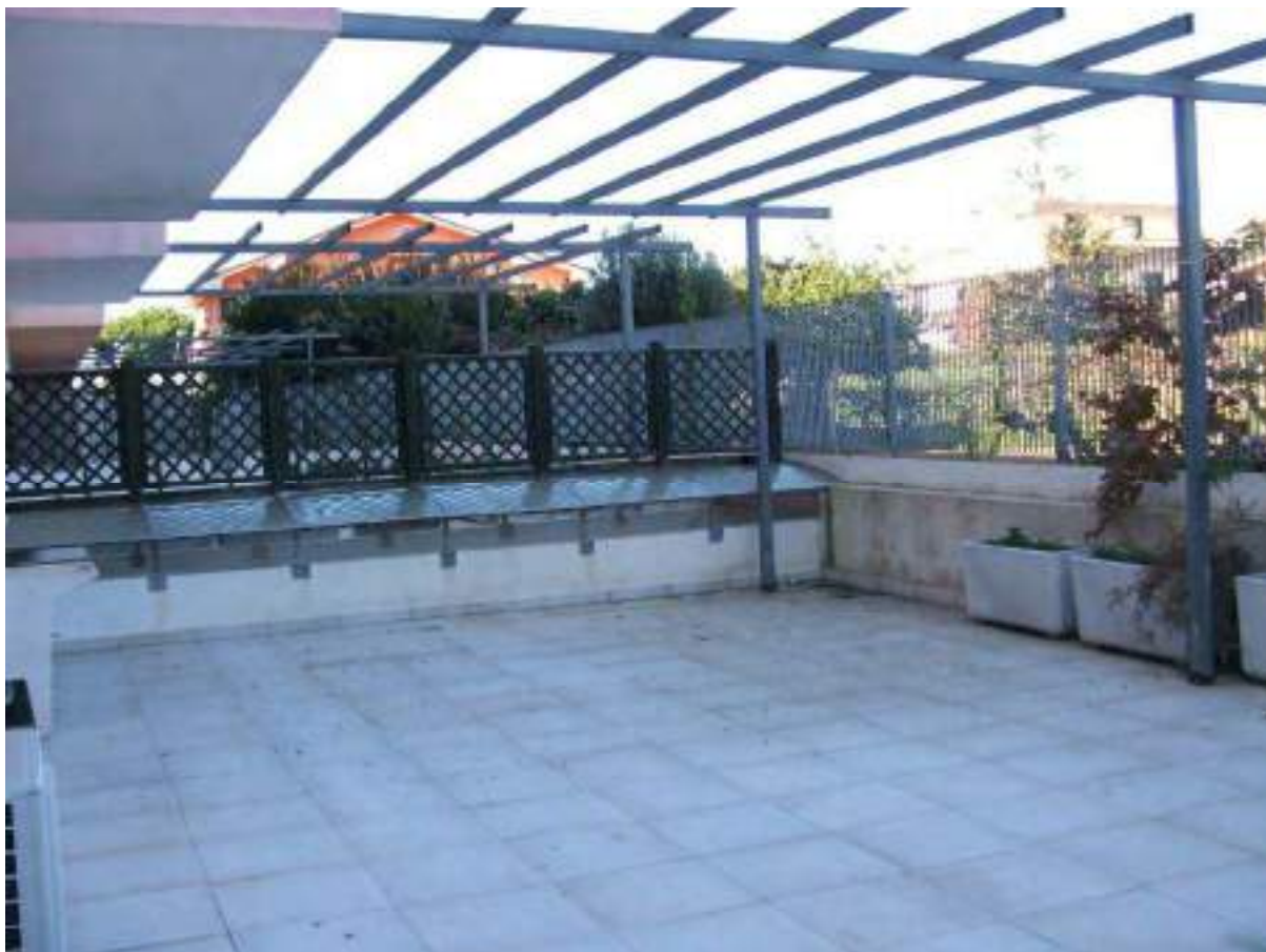
Foto n° 18 – Terrazzino appartenente ad unità immobiliare
