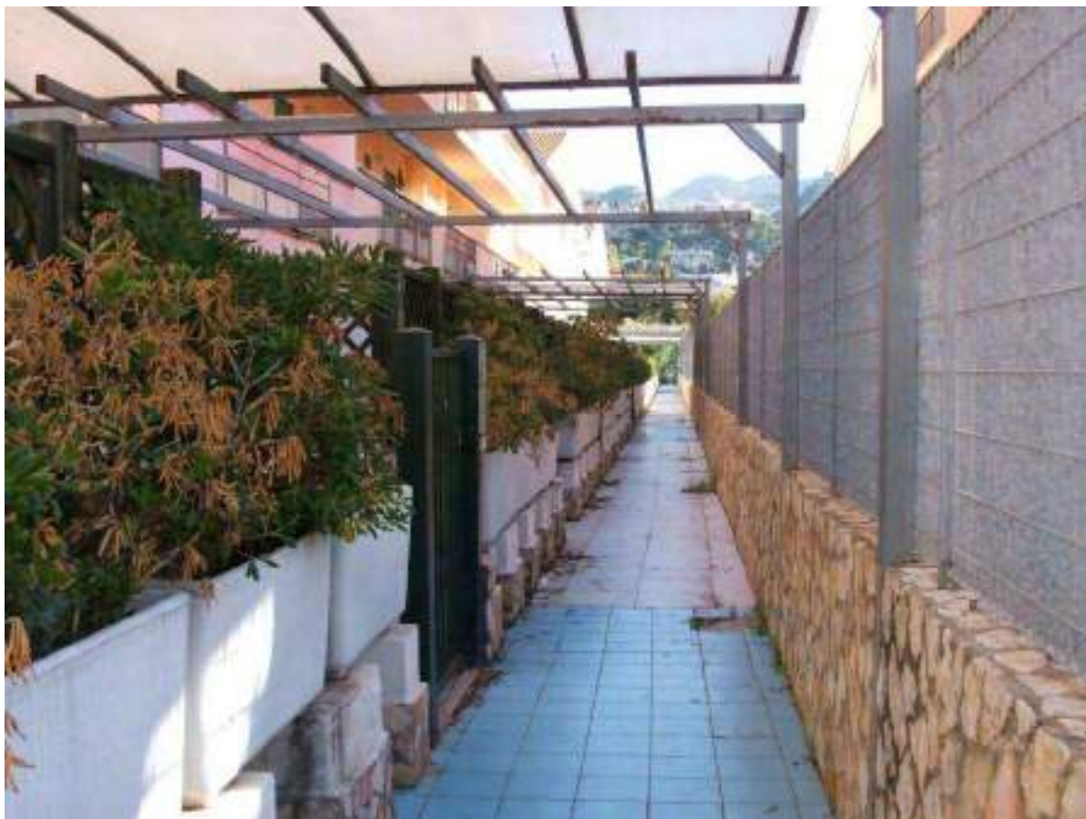
Foto n° 7 – Percorso pedonale di accesso alle unità immobiliari
