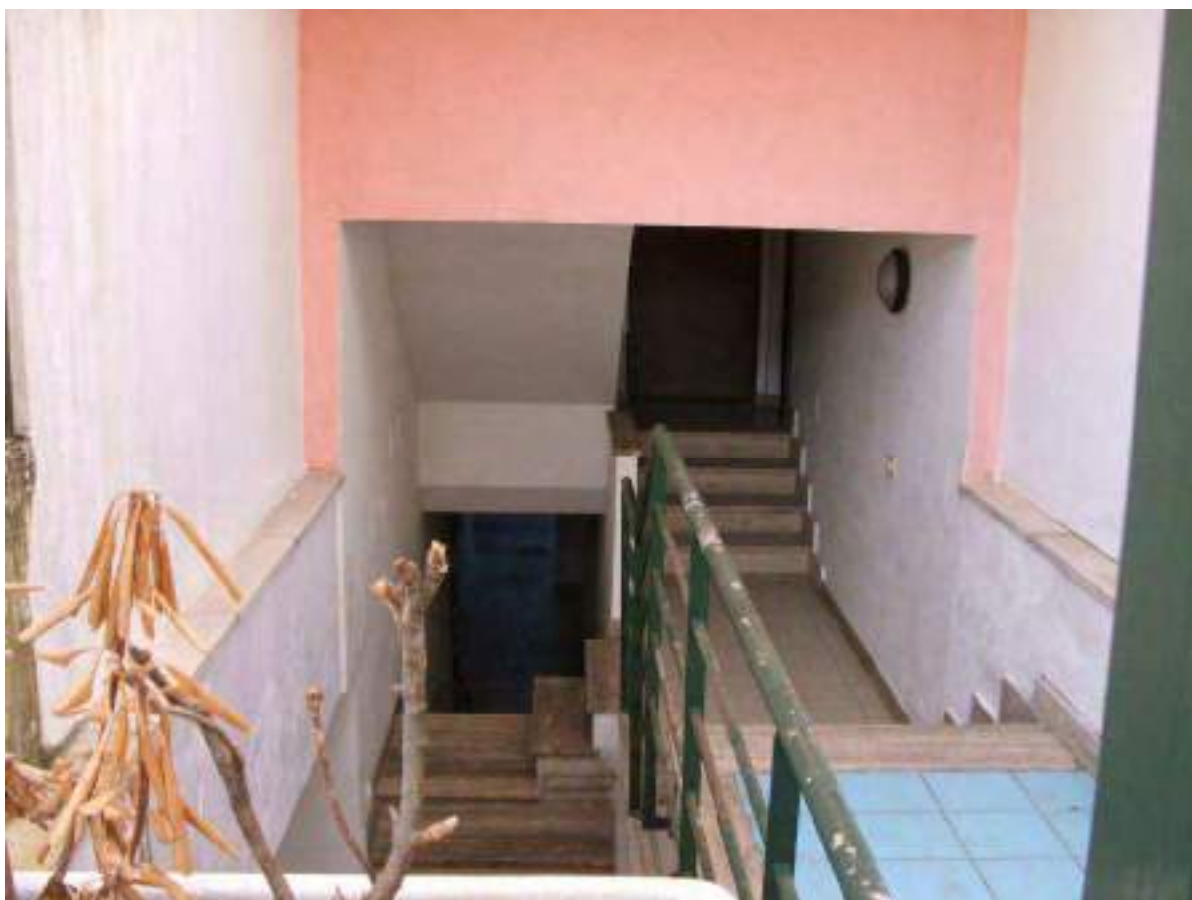
Foto n° 8 – Vano scala di accesso all'interrato
