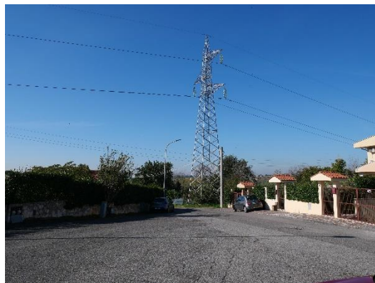
Part. 220 (Traliccio dell'elettrodotto)
