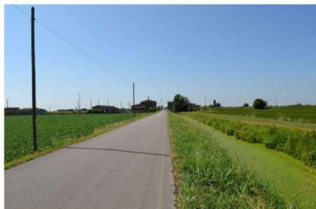
foto 18 - v. Beccascogliera - Oltre che al capoluogo, la via collega allo svincolo della SS434.
