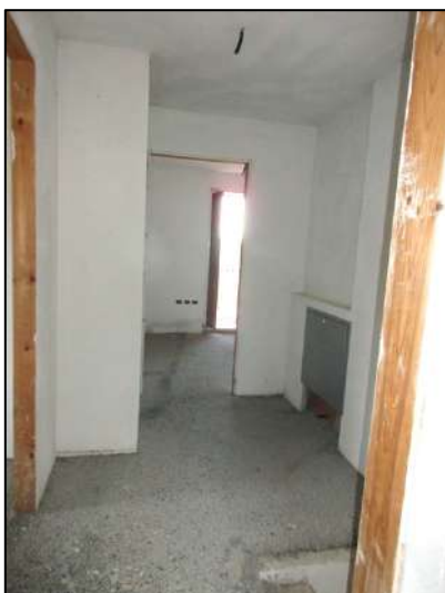
PIANO PRIMO disimpegno
