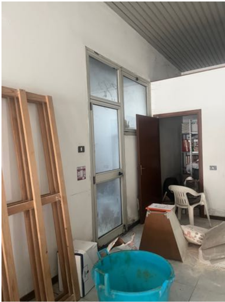
Vista dell'infisso con porta verso il sottoscala.
