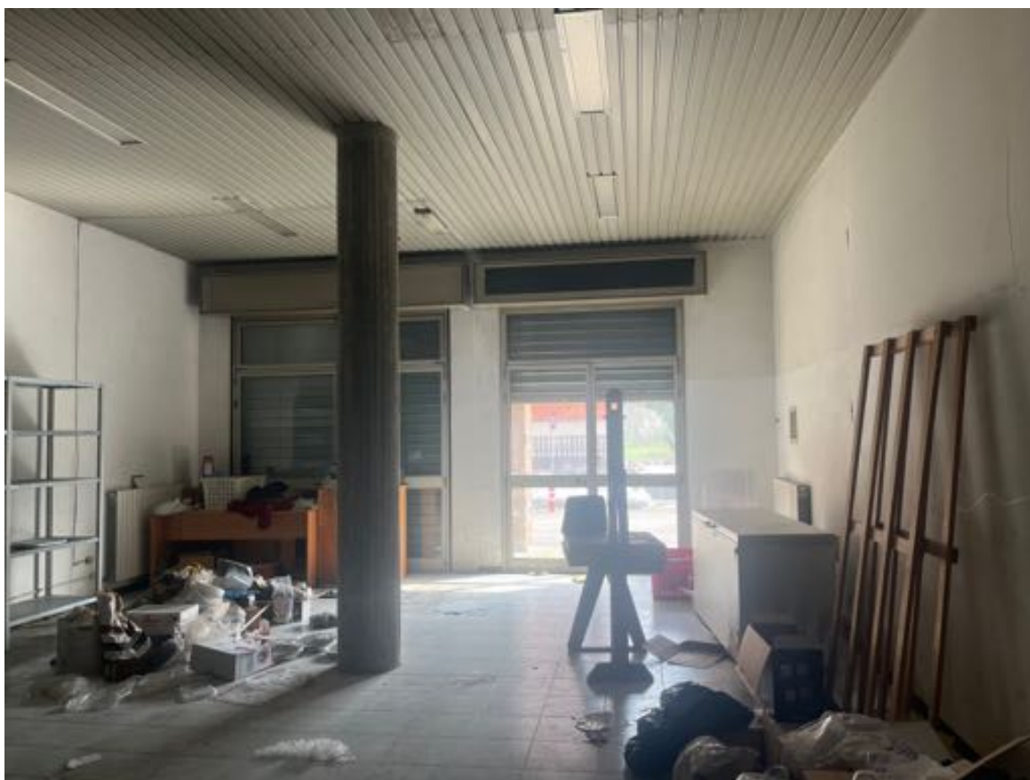
Vista dell'ampio vano unico verso la parete d'ingresso con le due vetrine.
