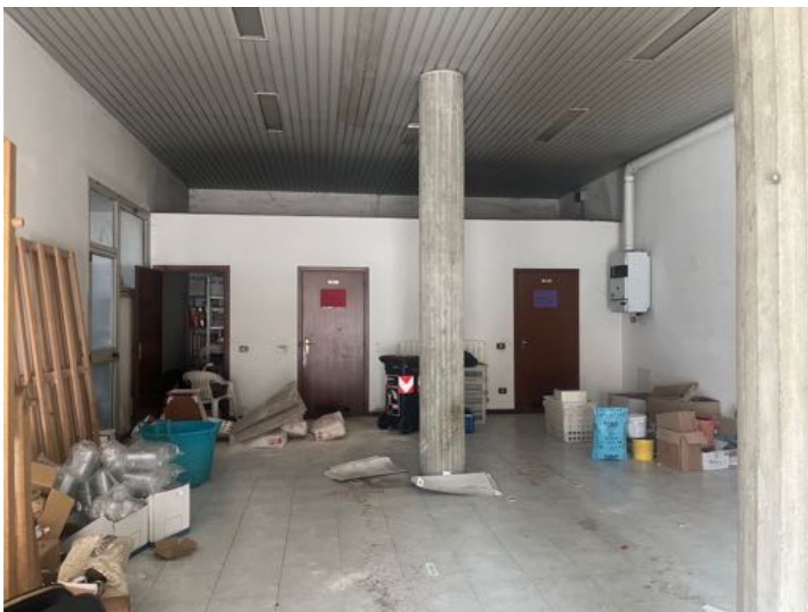
Controcampo verso il fondo del vano con il blocco servizi.
