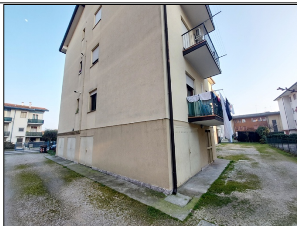
Foto n.4 – Esterni vista nord-ovest
