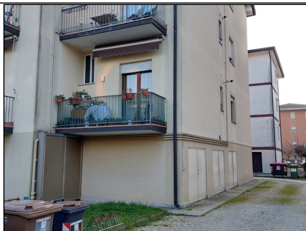
Foto n.3 – Esterni vista nord-est
