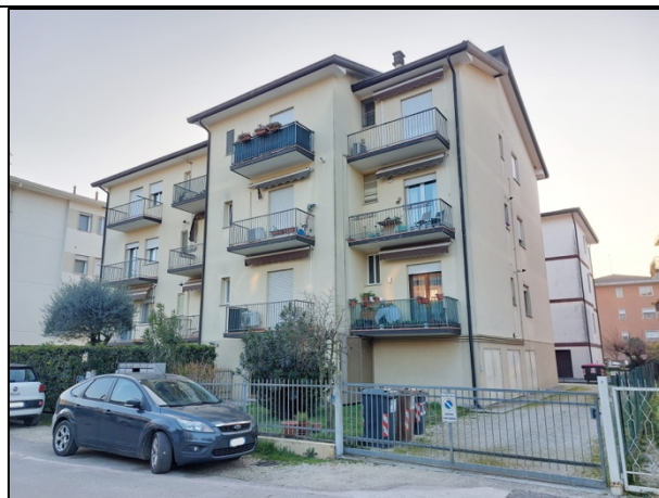
Foto n.2 – Esterni vista nord-est
