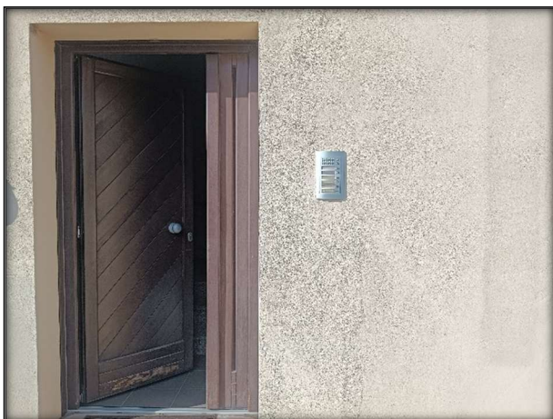
Foto 5 – Portoncino di ingresso comune in Via Romagna
