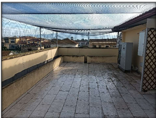
Foto 11 – Vista generale terrazza
