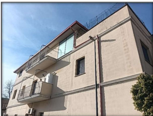
Foto 1 – Prospetto Via Romagna
