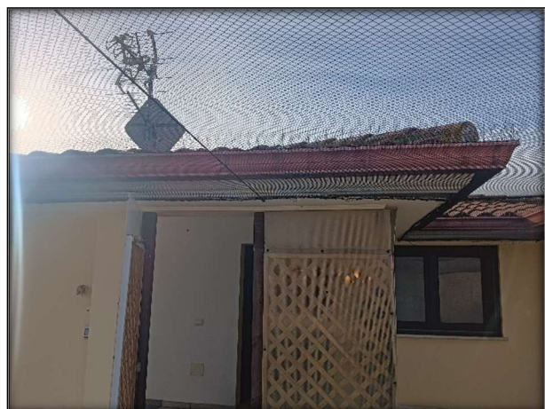
Foto 10 – Dettaglio porta di collegamento alla terrazza
