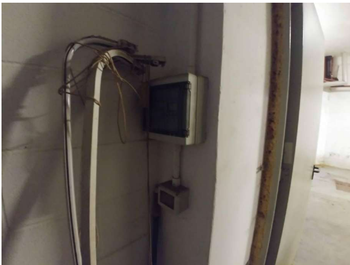
Figura 14 : interno Dep.(F.63 p.la 797 sub.42 - int.9)
