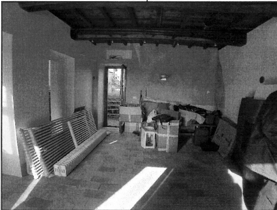
Foto 3 – vano piano terra.
