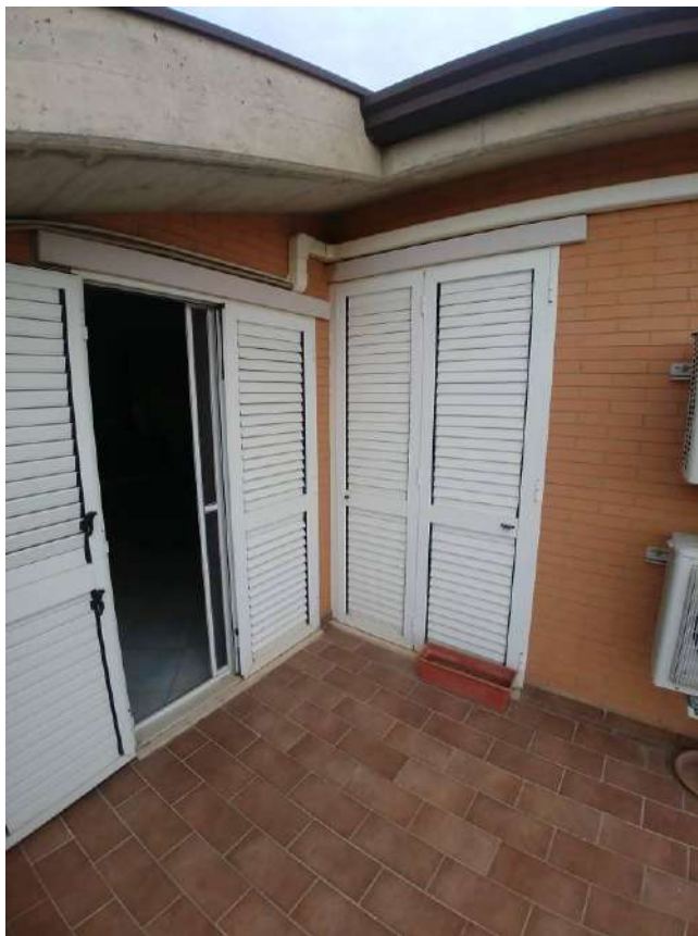
Figura 34 : Piano sottotetto (infissi esterni di accesso alle verande)
