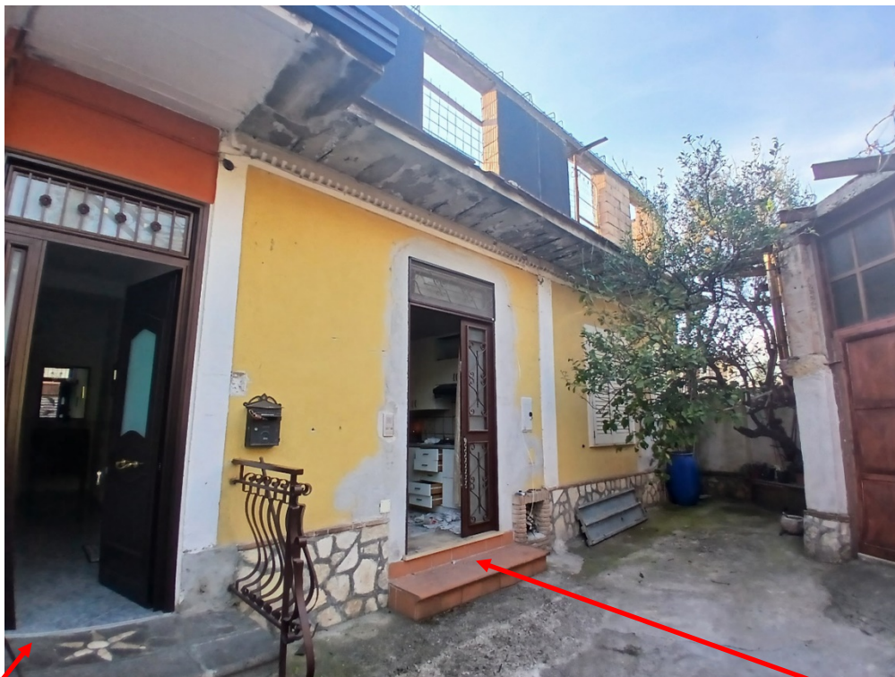
Unità immobiliare oggetto di pignoramento
