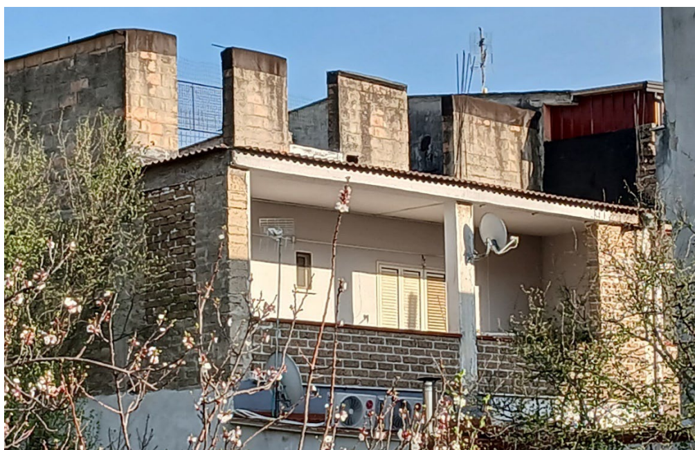
Unità immobiliare oggetto di pignoramento – prospetto ovest
