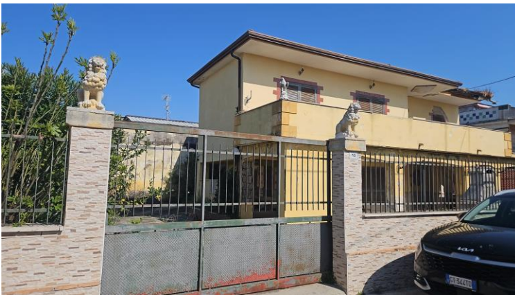
Viale D'Orta-Ingresso carrabile
