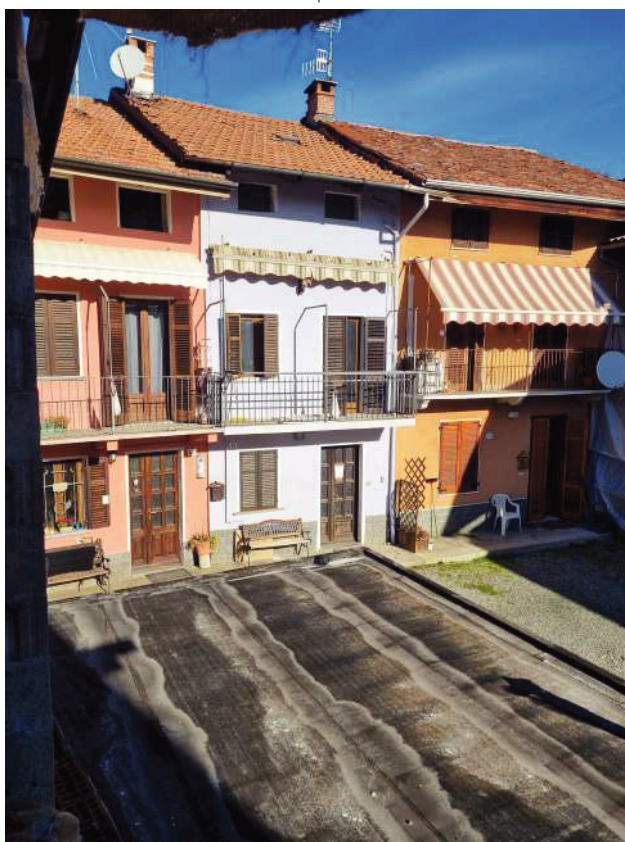
VISTA BENE 1 DA SOLETTA PRIMO PIANO SU AUTORIMESSA
