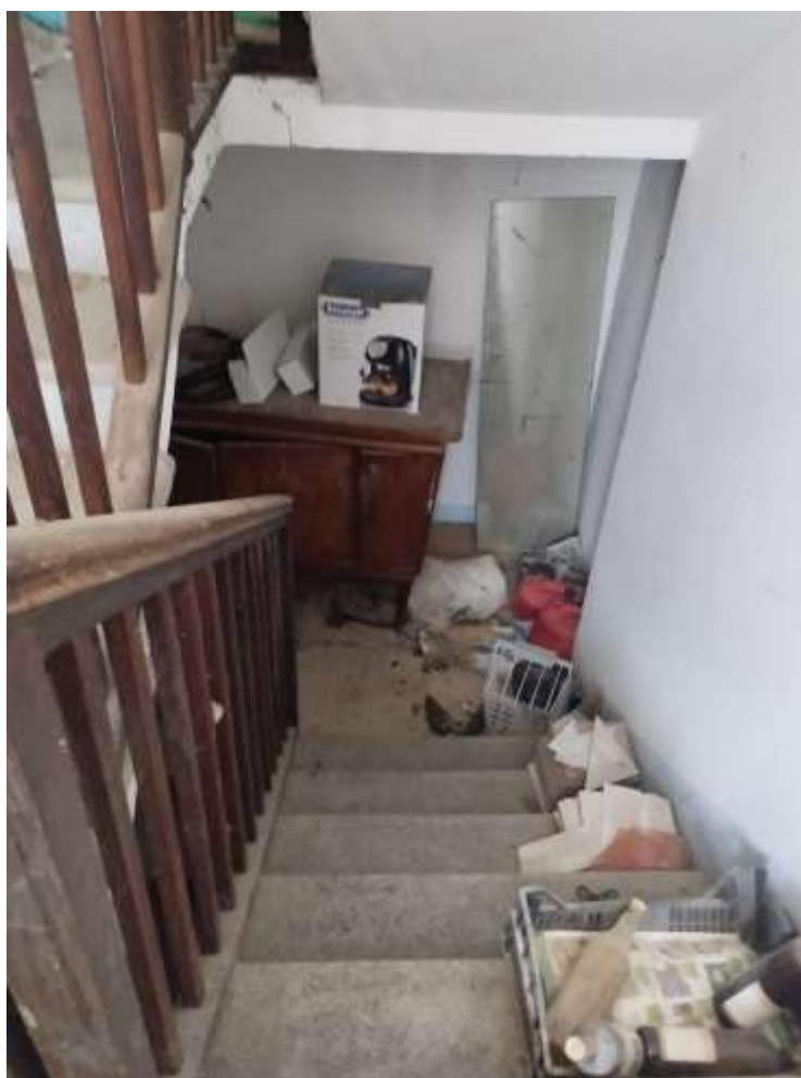
SCALA DI ACCESSO PIANO PRIMO SUB 2
