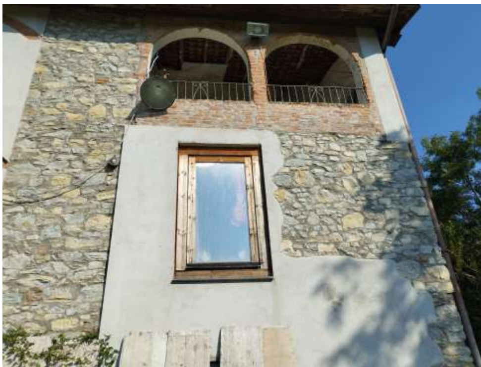
PARTICOLARE PIANO PRIMO E TERRAZZINO COPERTO AL PIANO SECONDO
