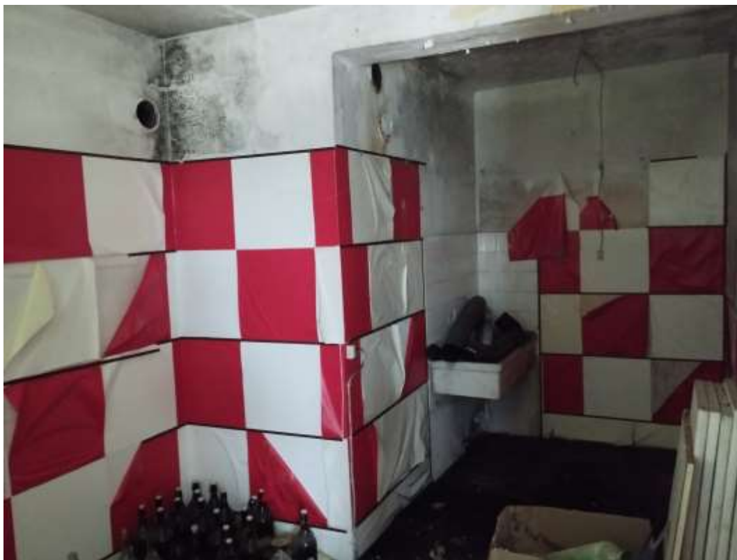
INGRESSO PIANO PRIMO SUB 2
