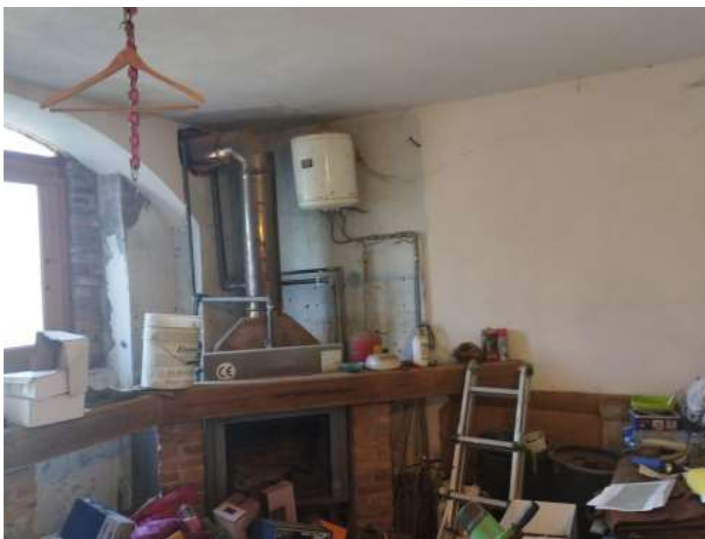
LOCALE INGRESSO CON CAMINO SUB 1
