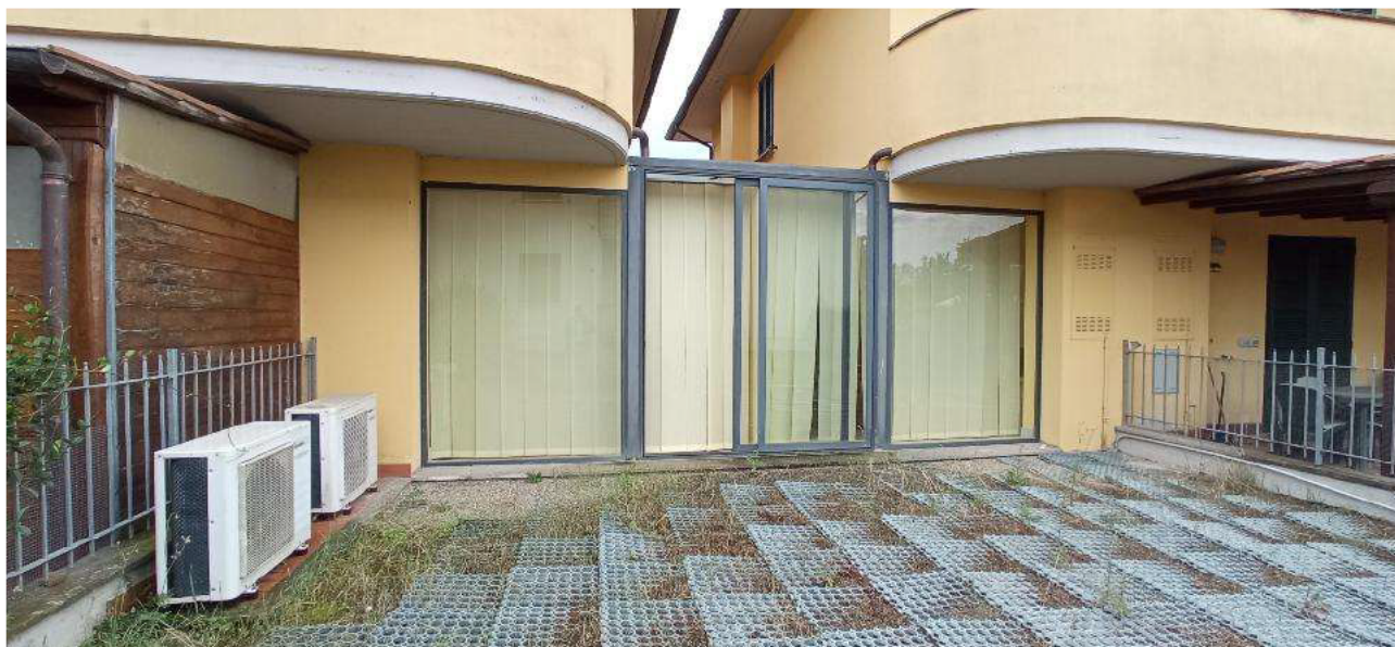
Foto n. 12. Vani 1 e 2 dal giardino retro
