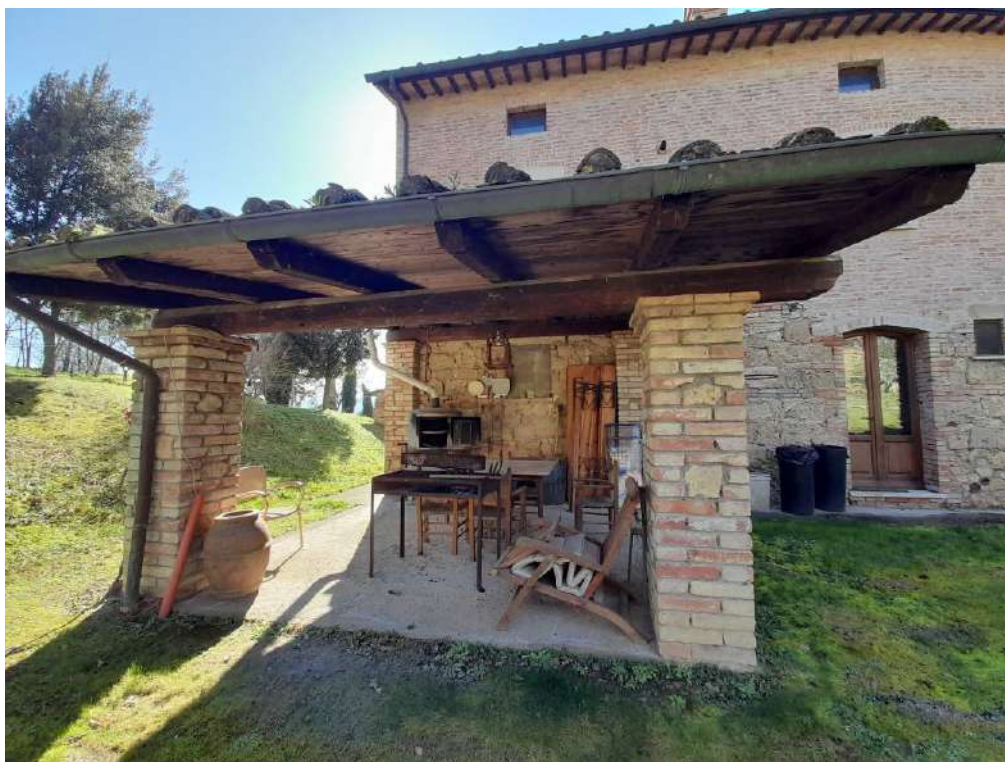
Portico prospetto nord est
