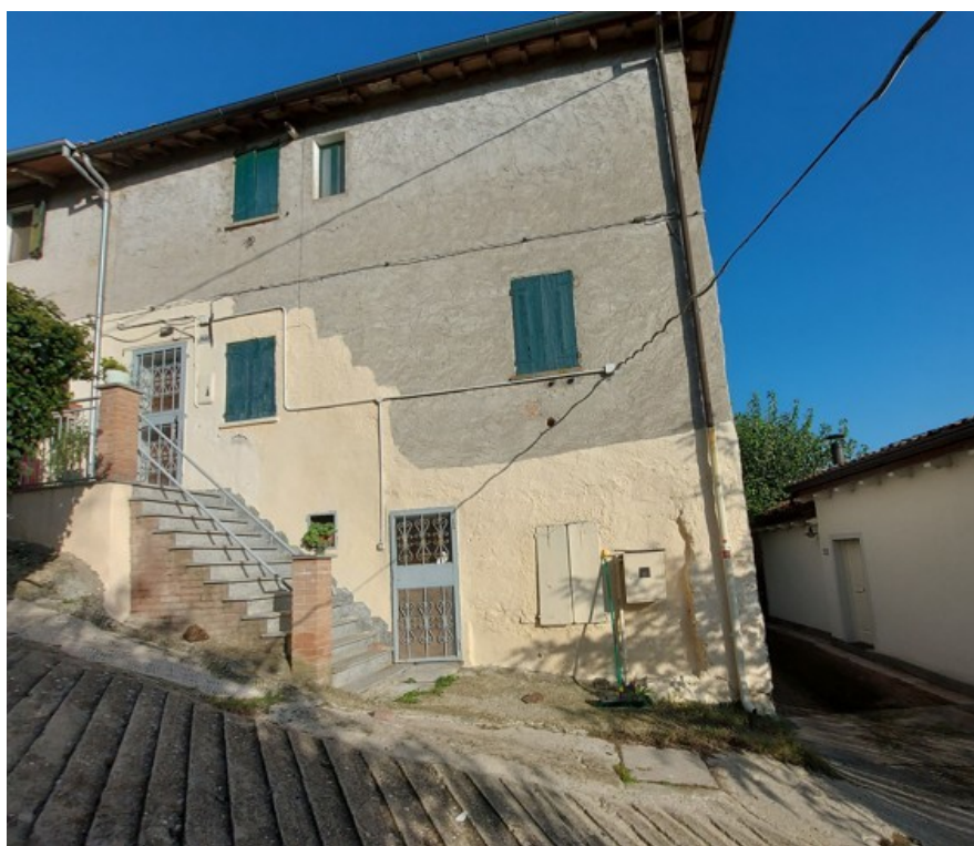
Fotografia E.4 - fronte abitazione
