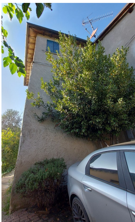
Fotografia E.6 - Retro abitazione
