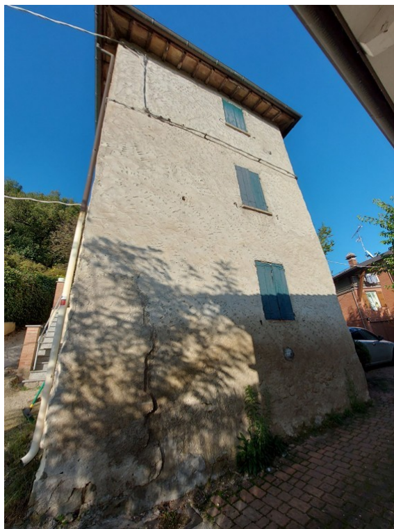
Fotografia E.5 - Fianco abitazione
