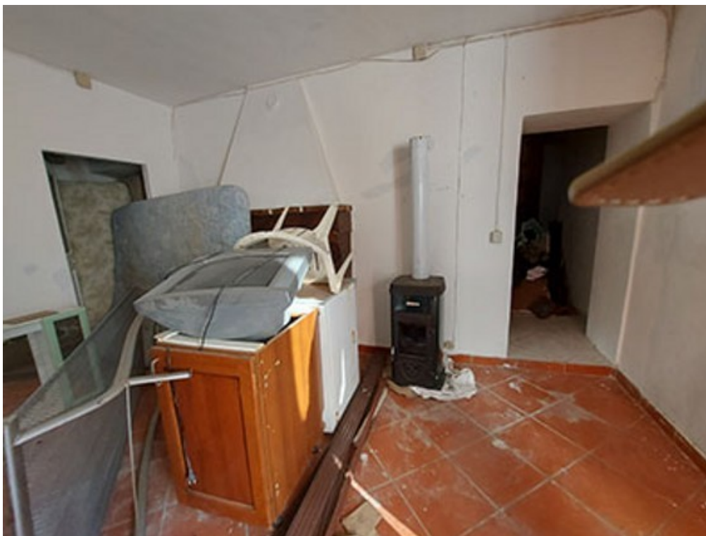
Fotografia E.10 - Piano primo: soggiorno
