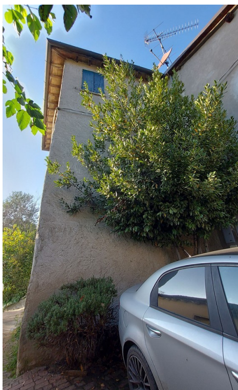
Fotografia E.5 - Retro abitazione
