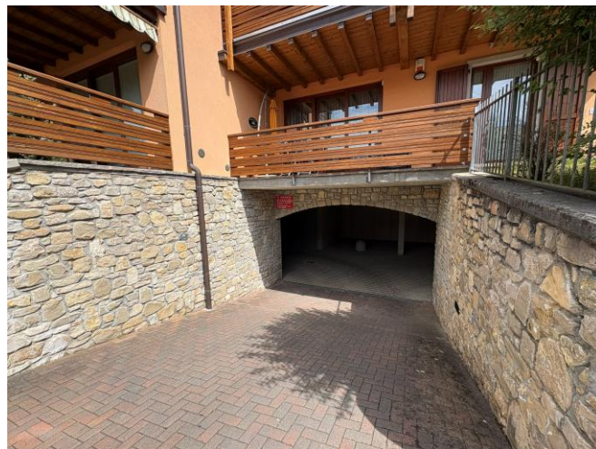
Vista ingresso autorimessa
