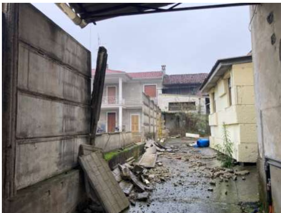
FOTO N.2 La corte dall'ingresso carraio
