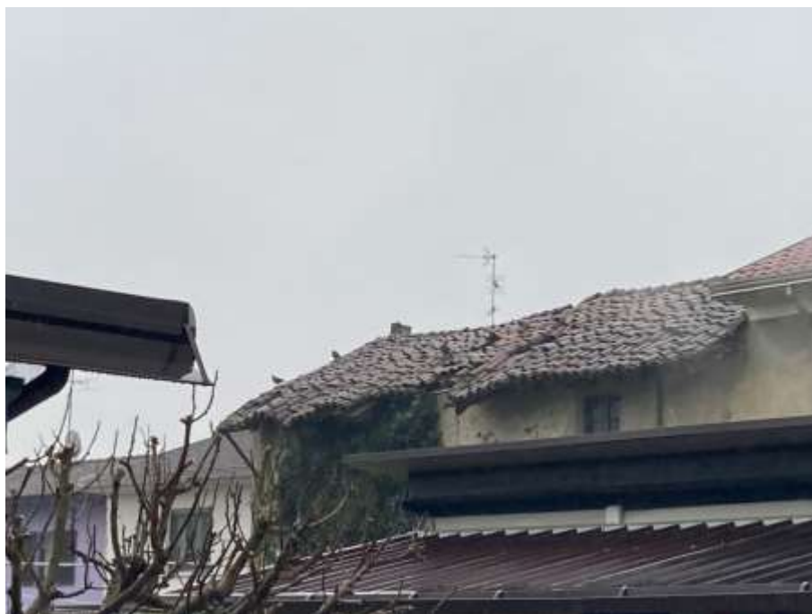
FOTO N.5 Tetto abitazione lato nord
