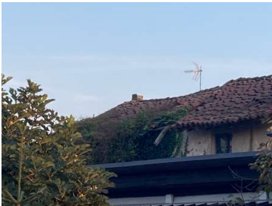
FOTO N.3 Tetto abitazione lato nord
