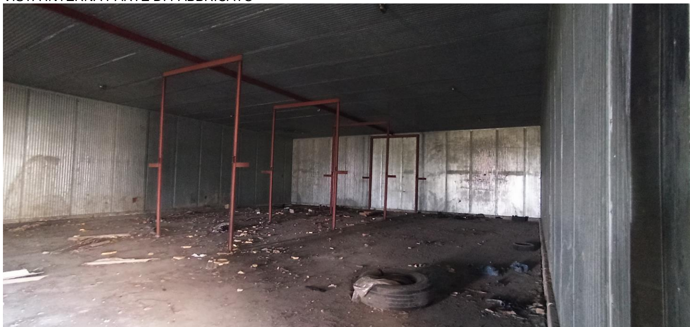
VISTA INTERNA PARTE DI FABBRICATO
