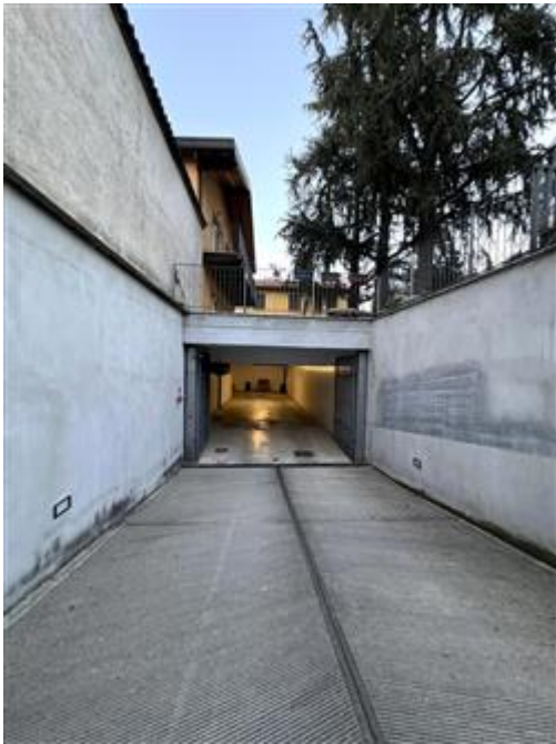
Ingresso corsello autorimessa
