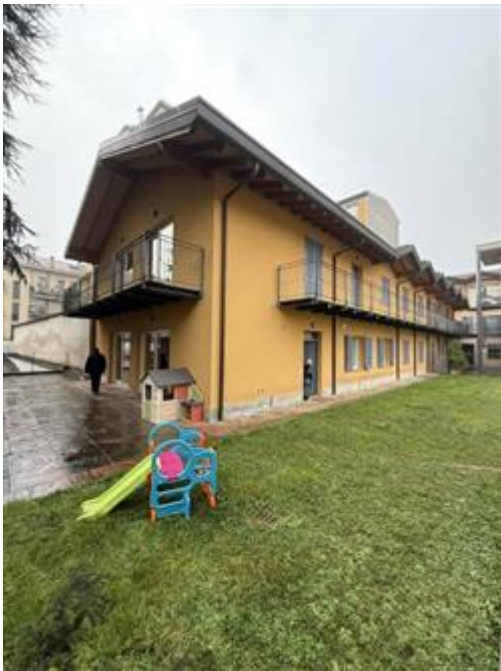
Fabbricato - corte interna
