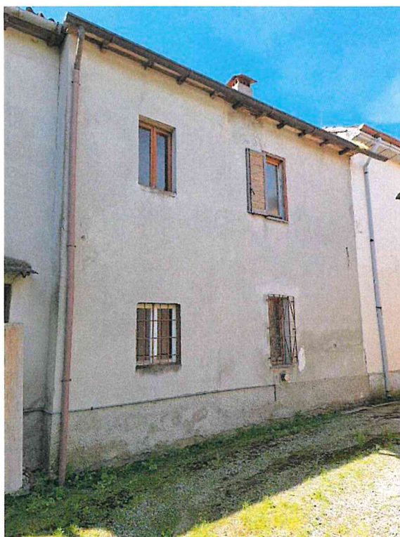
foto 4 – vista esterna dell'immobile, prospetto Nord.
