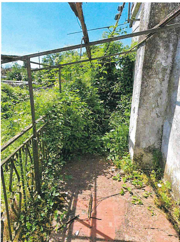
foto 19 – vista esterna dell’immobile P.1°, balcone.
