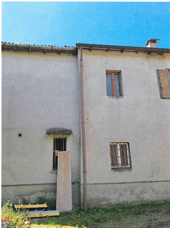
foto 5 – vista esterna dell’immobile, prospetto Nord.
