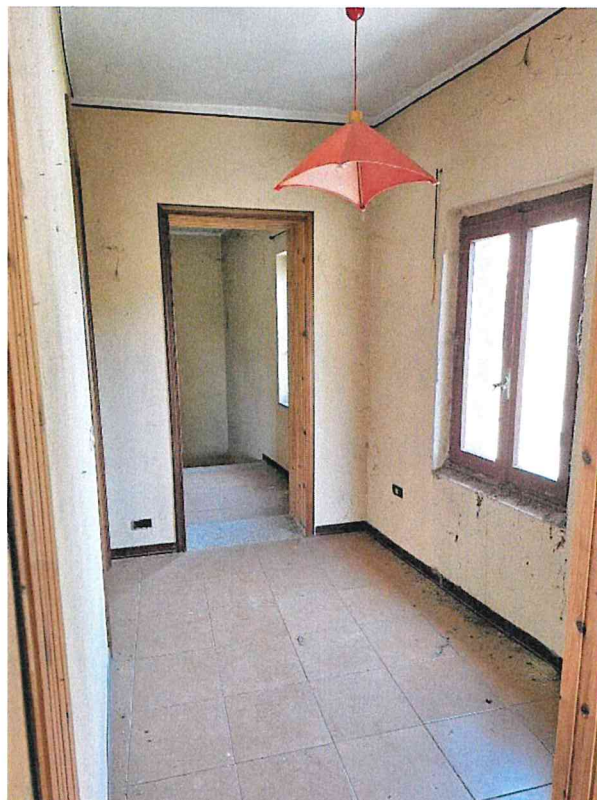
foto 14 – vista interna dell’immobile P.1°, disimpegno 1.
