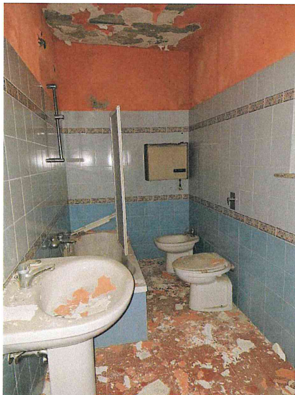
foto 11 – vista interna dell’immobile P.T., servizio igienico.
