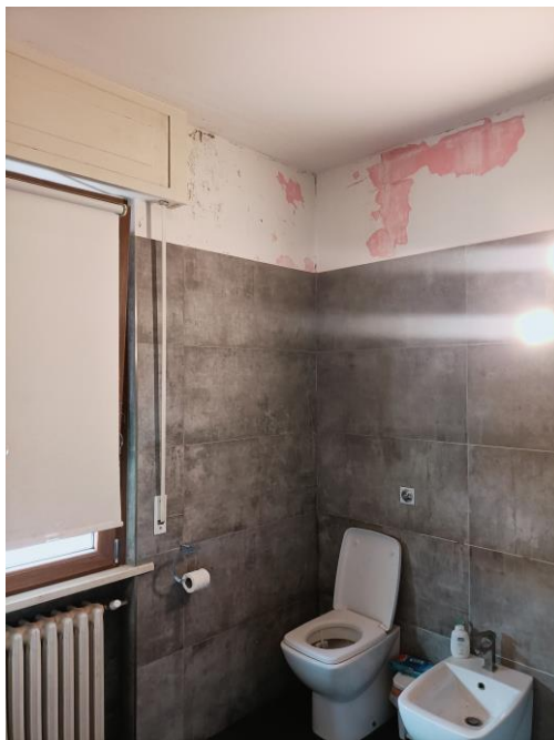
APPARTAMENTO PIANO PRIMO - Bagno
