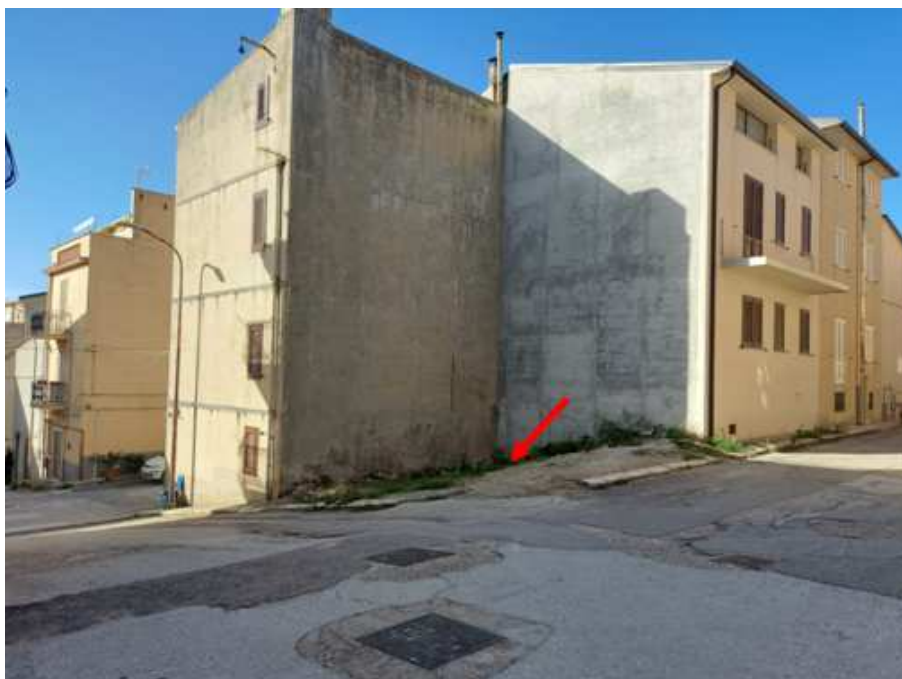
Foto 4 – Via Umbria – Indicazione dell’area edificabile “LOTTO 2”
