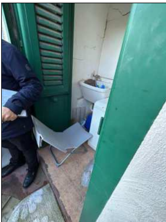
Foto 27/28 - terrazza/ lavanderia - p. secondo- stato tipologico e conservativo
