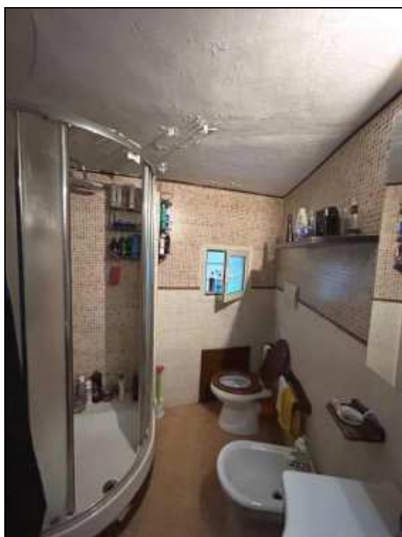
Foto 15/16 - servizio igienico - p. primo - stato tipologico e conservativo
