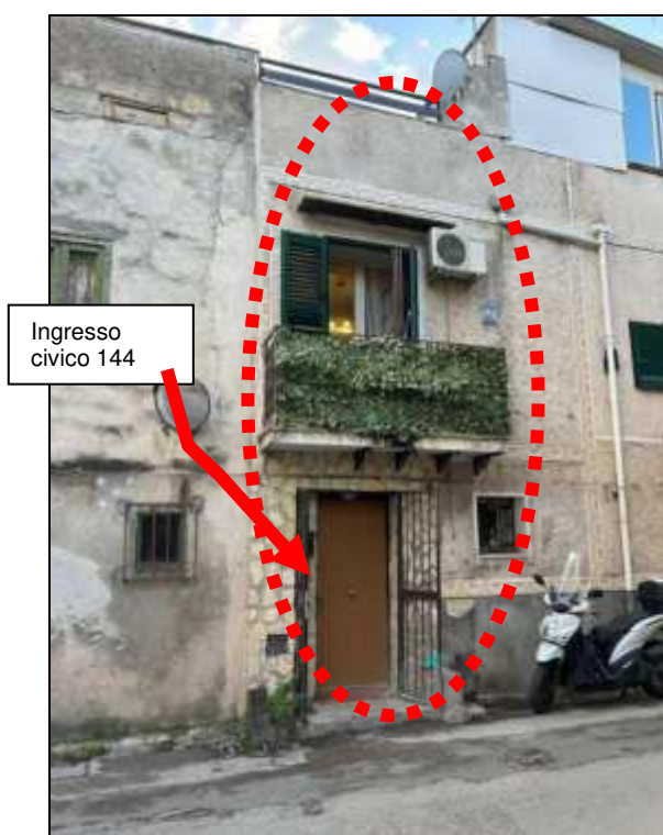
Foto 3/4 - prospetto principale -particolare accesso al civico 144 di questa via Cruillas - Palermo
